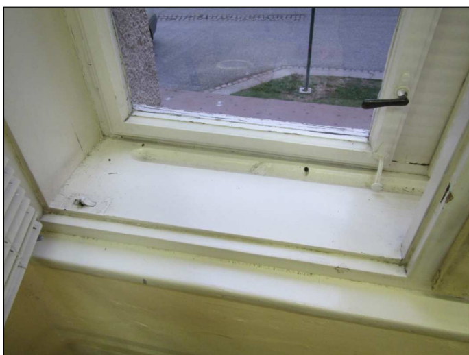
Kování–klička křídla, stavěč křídla, distančník křídel parapet–žlábek pro odvod zkondenzované vody
