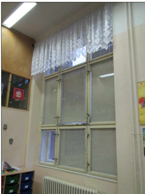
Pohled na okno z interiéru
