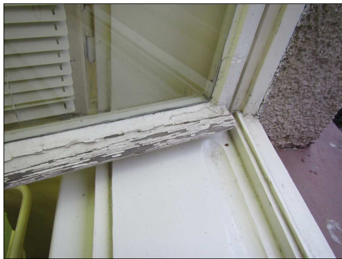
Pohled na venkovní křídlo –okapnička vnějšího křídla, drážky rámu
