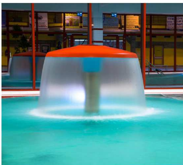
AX.3 - Vodní deštník Q=34 \text{ m}^3/\text{h}
