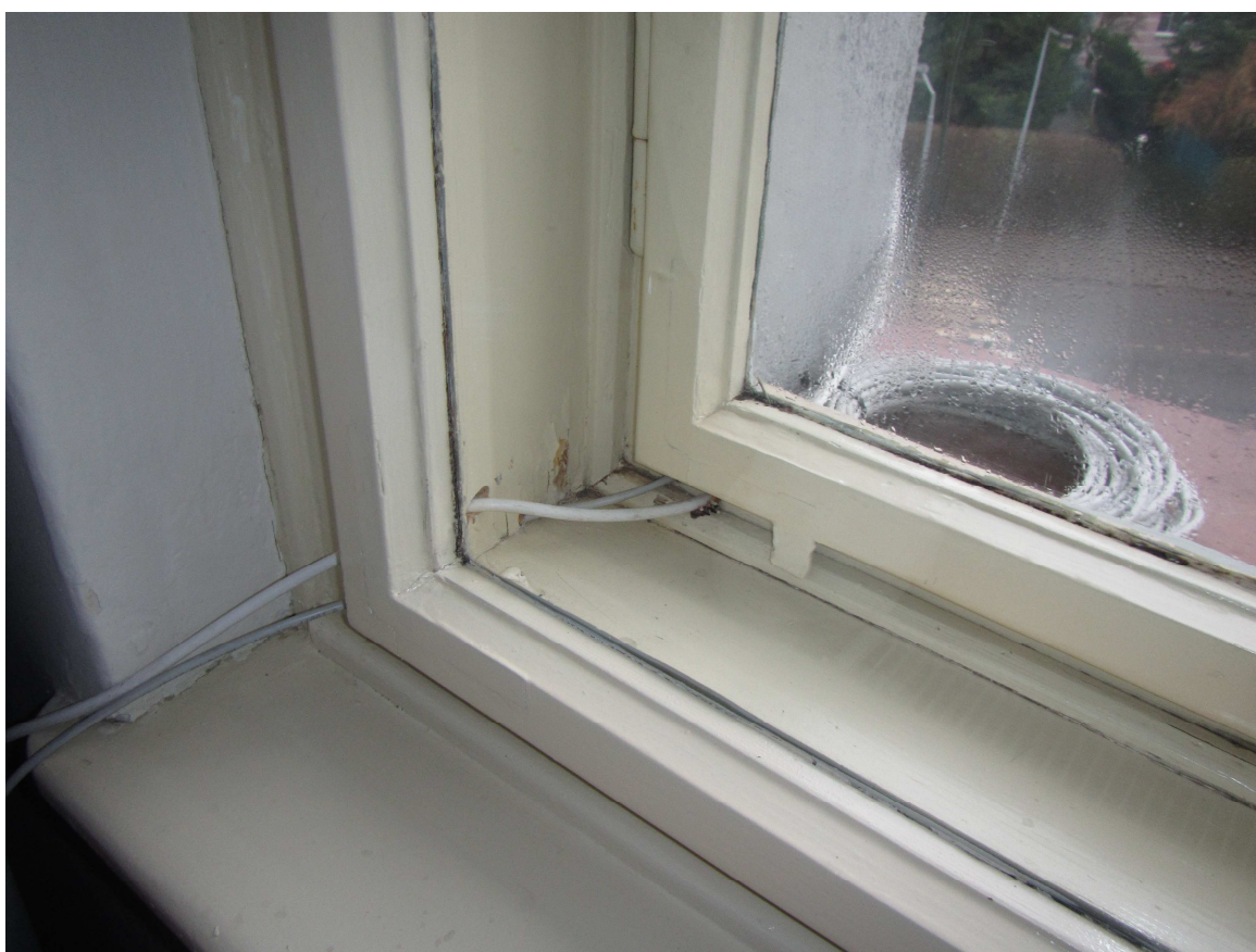
OKNO ŠPALETOVÉ – POŠKOZENÍ ANTÉNNÍMI KABELY
