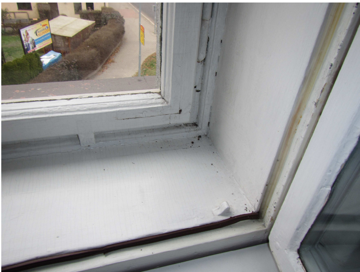
OKNO ŠPALETOVÉ – NEFUNKČNÍ DISTANČNÍKY, NEVHODNÉ TĚSNĚNÍ
