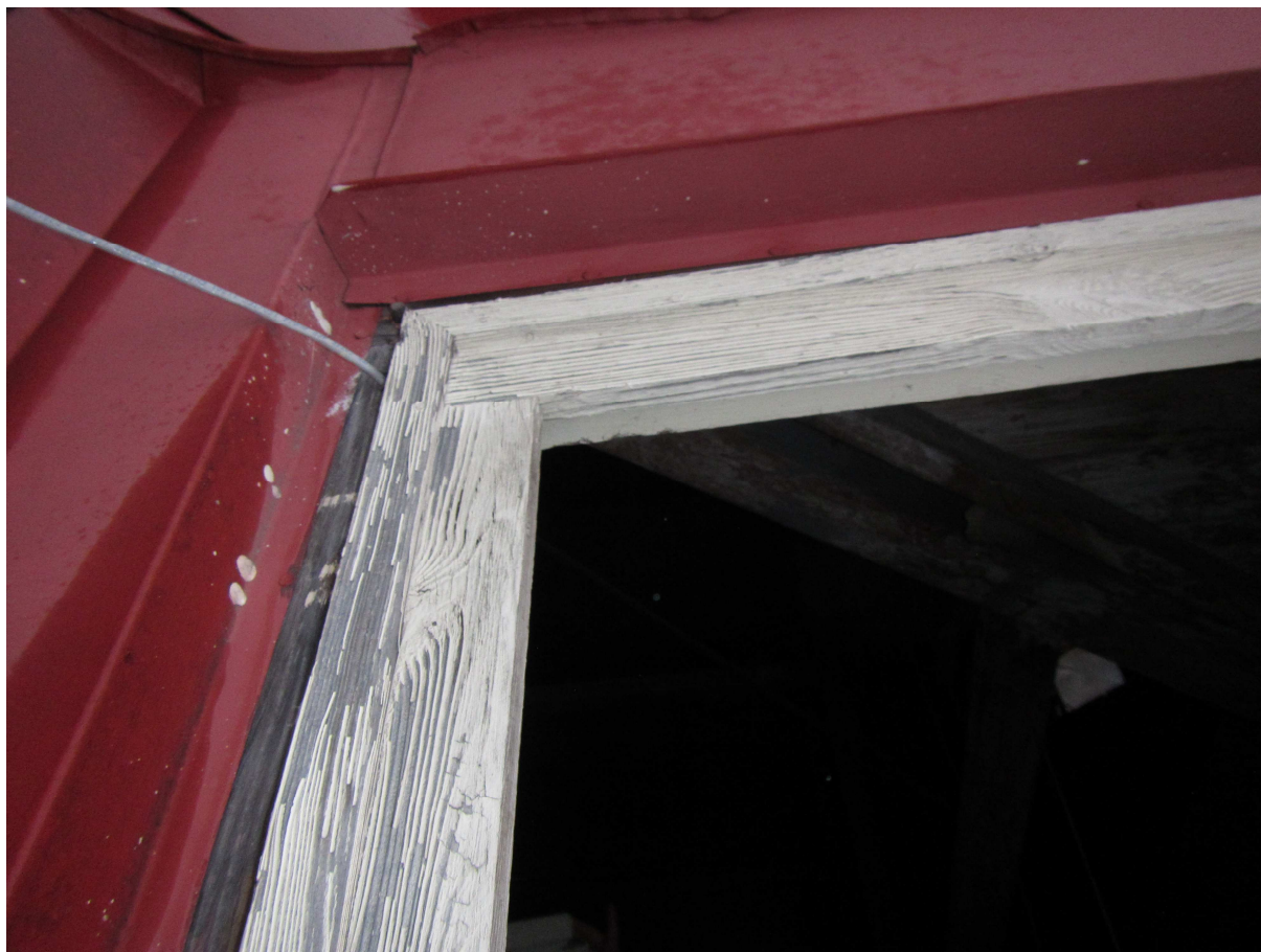
OKNO NA PŮDĚ – ŠPATNÉ PROVEDENÍ NEDOSTATEČNÉ OPLECHOVÁNÍ – POHLED NA HORNÍ ROH
