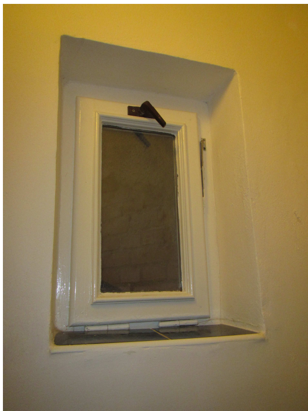
OKNO S IZOLAČNÍM DVOJSKLEM - PONECHANÉ
