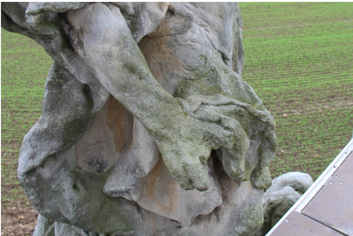
Obrázek 26 Detail poškození, chybějící prsty na pravé ruce Sv. Floriána
