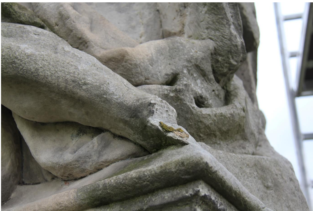
Obrázek 30 Poškození, chybějící noha pravého anděla
