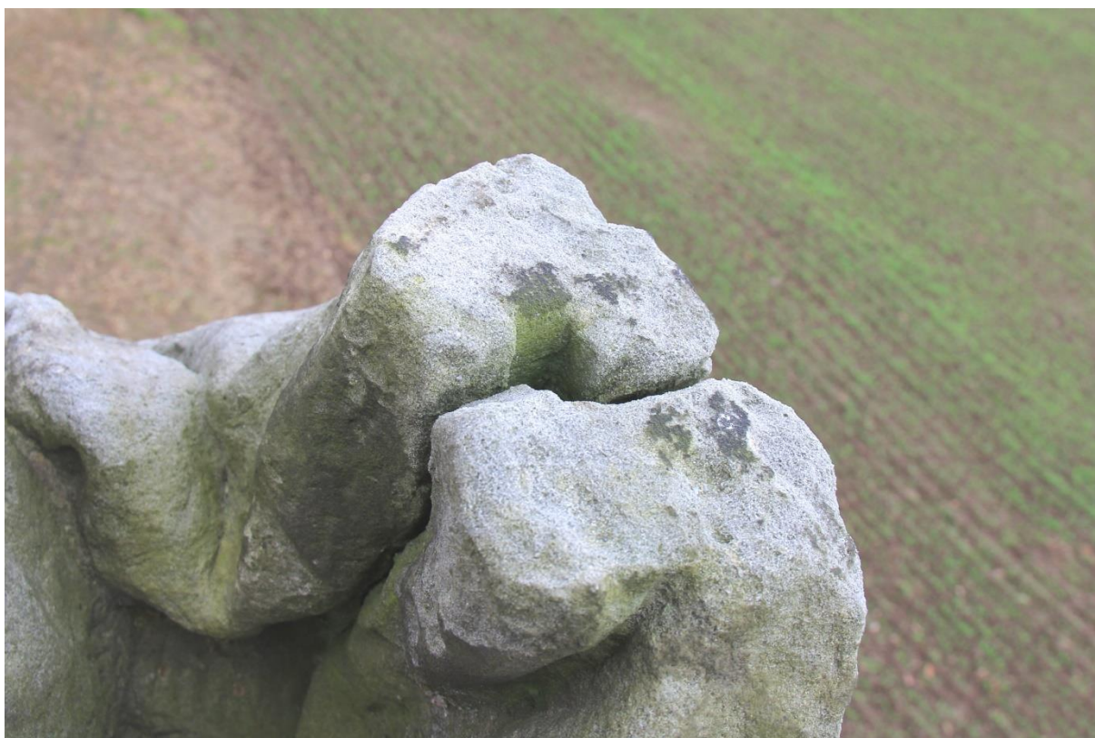
Obrázek 28 Prasklina, kterou spona způsobila
