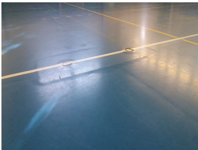
Foto3: Vytlačená dilatační spára a vyvýšený betonový základ
