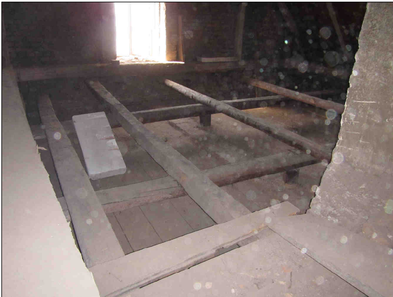
ČÁST „A“ U ŠTÍTOVÉ STĚNY DO NÁMĚSTÍ PO ODSTRANĚNÍ FOŠEN „DRUHÉ HORNÍ PODLAHY“
