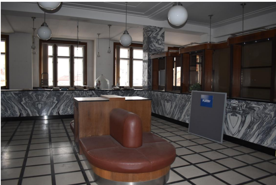
Současný stav přepážkové haly
