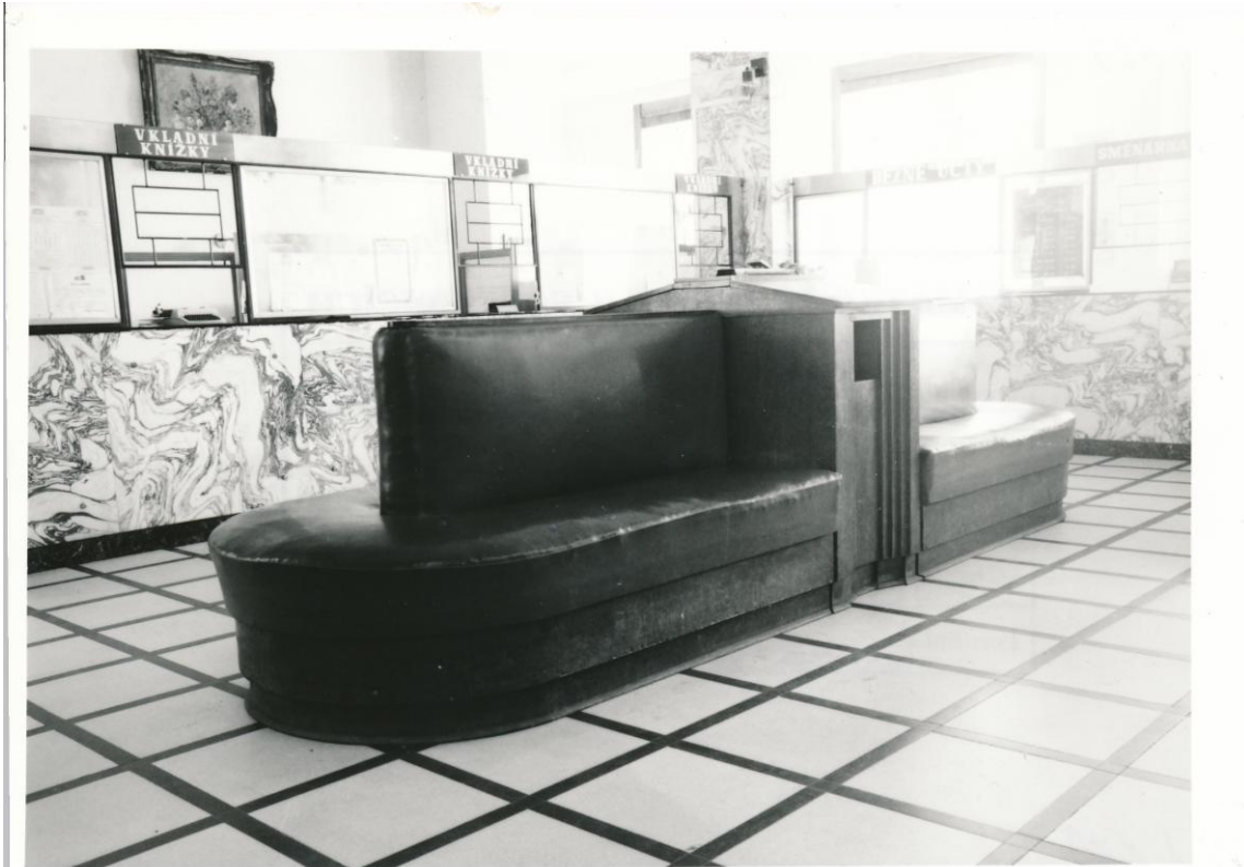
Stav přepážkové haly před rekonstrukcí v 90. letech 20. století
