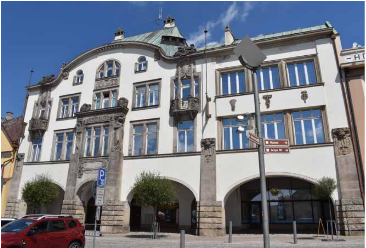
Obr. 8: Pohled na hlavní fasádu (Veselá, 2022).
