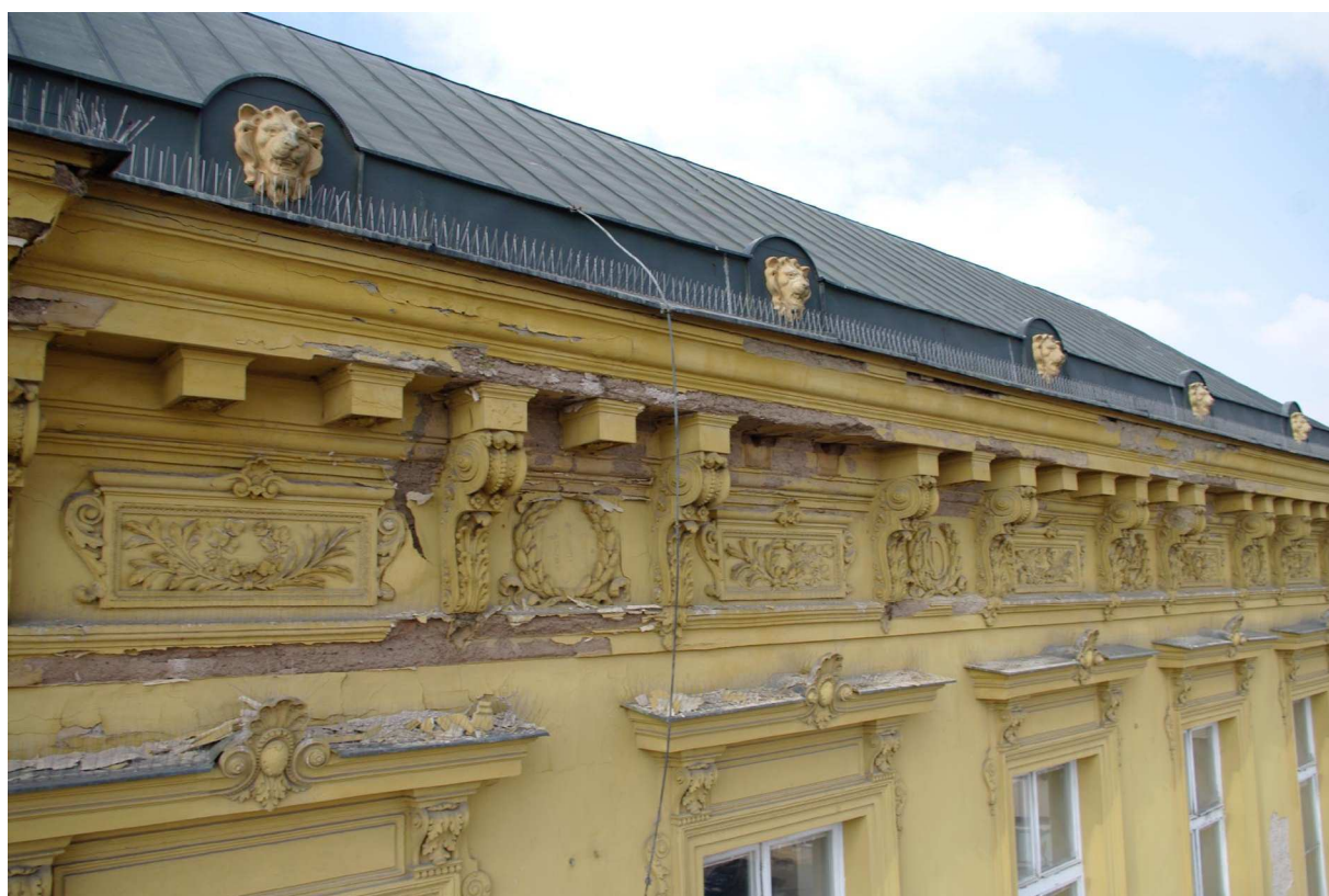
Obr. 12: Detail výrazně poškozené štukové výzdoby pod zaatikovým žlabem (foto: Kudrnovský 2012).
