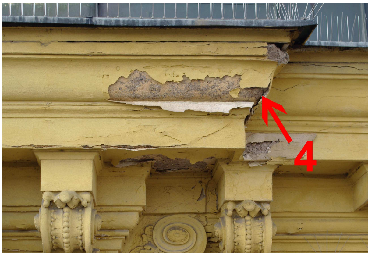
Obr. 16: Detail odběru vzorku s makroskopicky viditelnou původní probarvenou omítkou (foto: Kudrnovský 2012).
