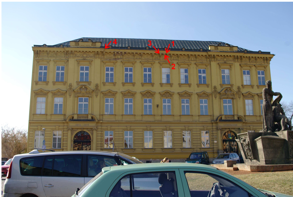
Obr. 15: Východní průčelí s vyznačením odběru vzorků pro potřeby restaurátorského průzkumu (foto: Kudrnovský 2012).
