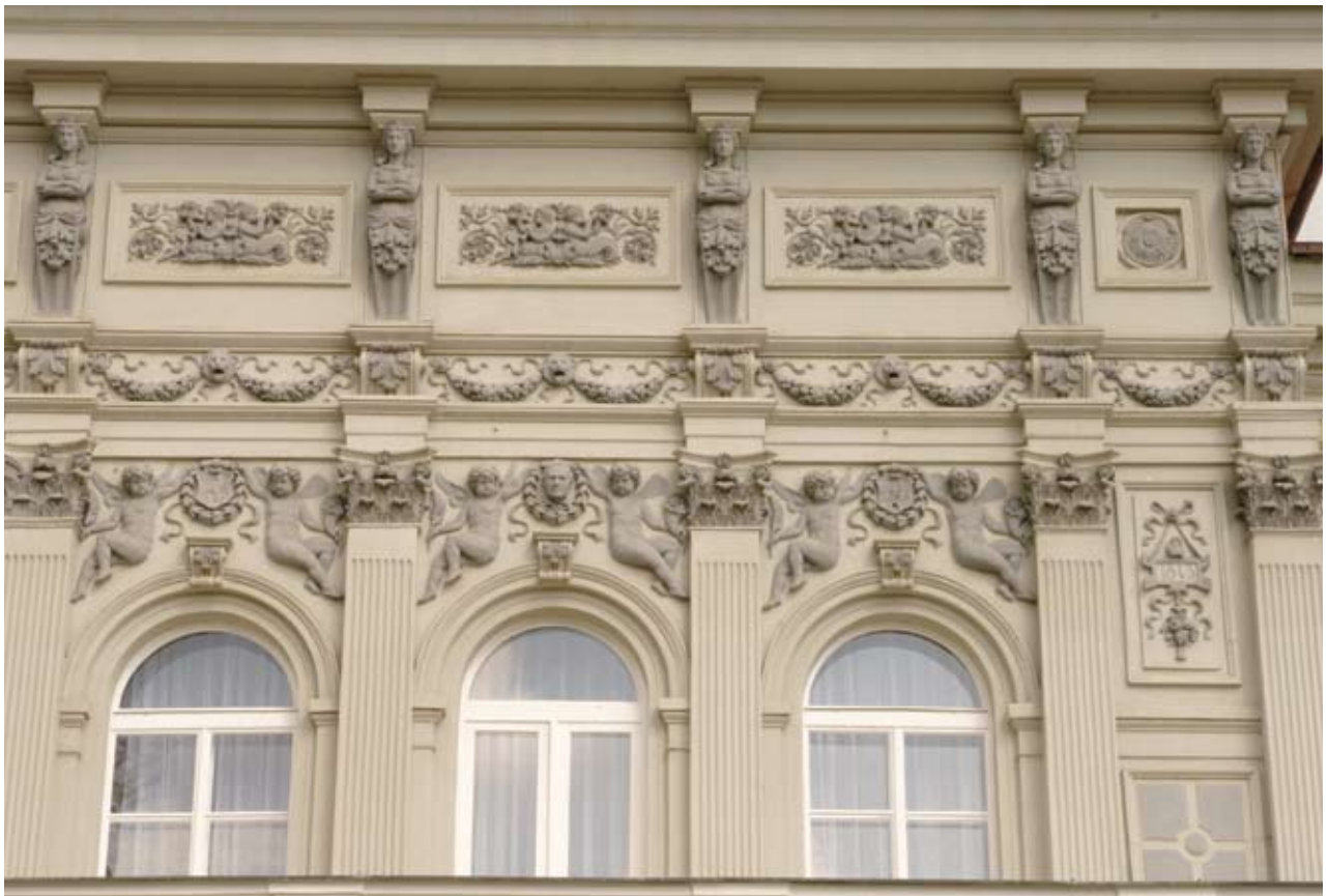
Obr. 146: Dominující střední díl jižního průčelí opatřený bohatou štukovou výzdobou (Kudrnovský, 2015).
