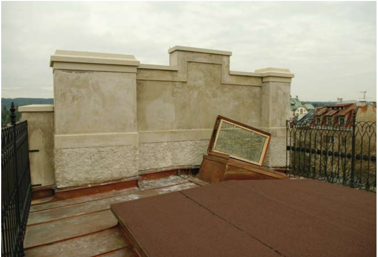
Obr. 184: Pohled na temeno báňové střechy a štítovou zeď střešního pavilonu (Kudrnovský, 2017).
