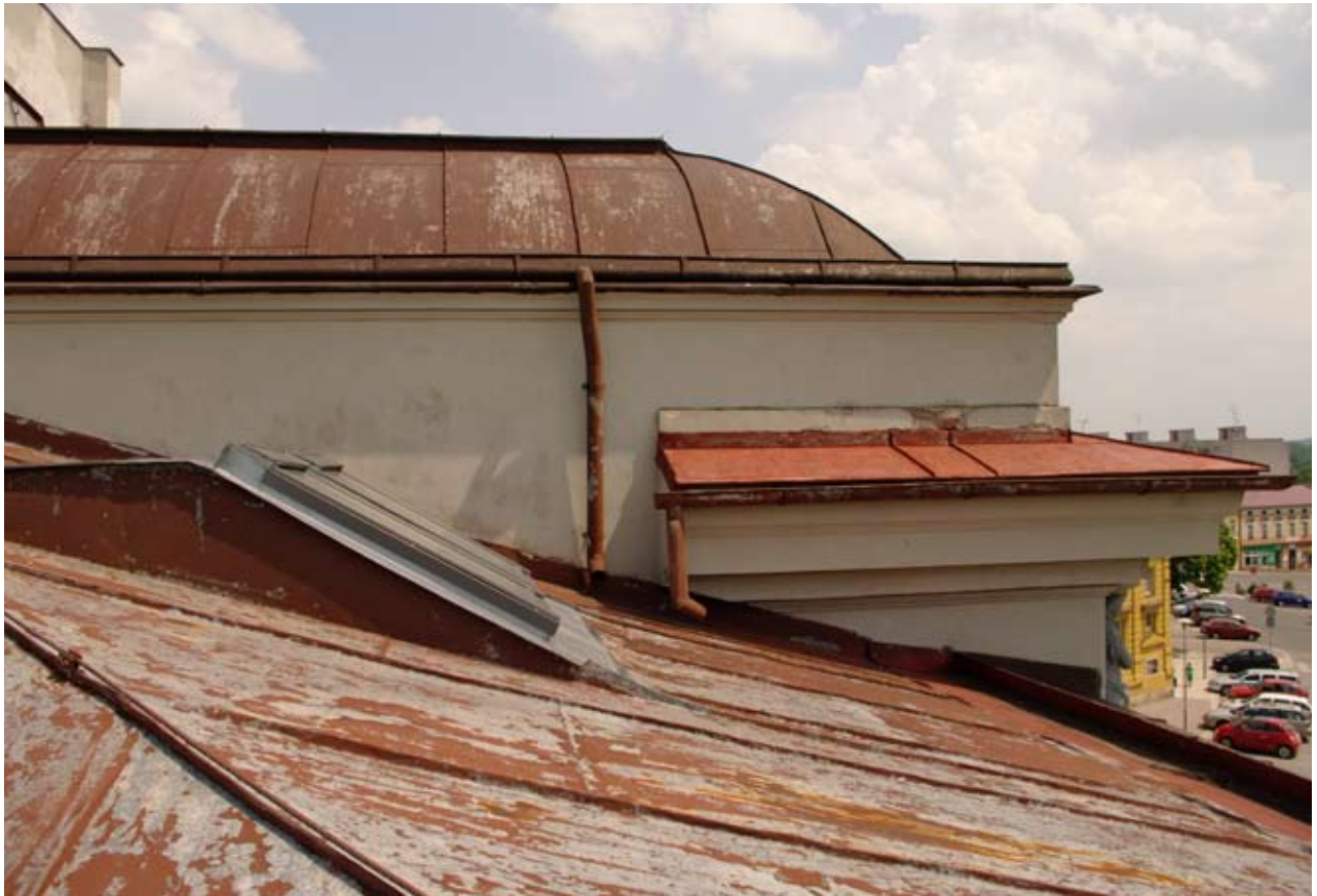
Obr. 170: Pohled na jihozápadní část valbové střechy a báňovou střechu Hankova domu (Kudrnovský, 2015).
