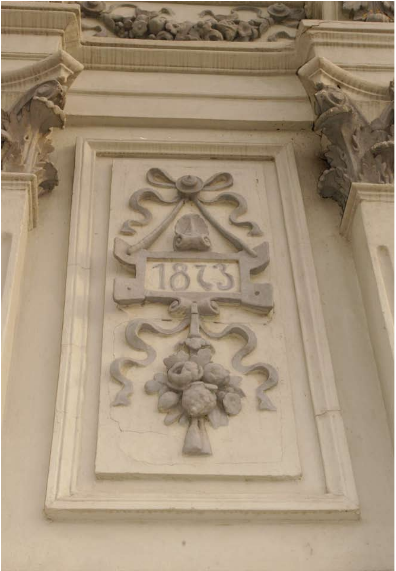
Obr. 153: Zdobná kartuše situovaná v úrovni otvorů 2NP středního dílu jižního průčelí (Kudrnovský, 2015).
