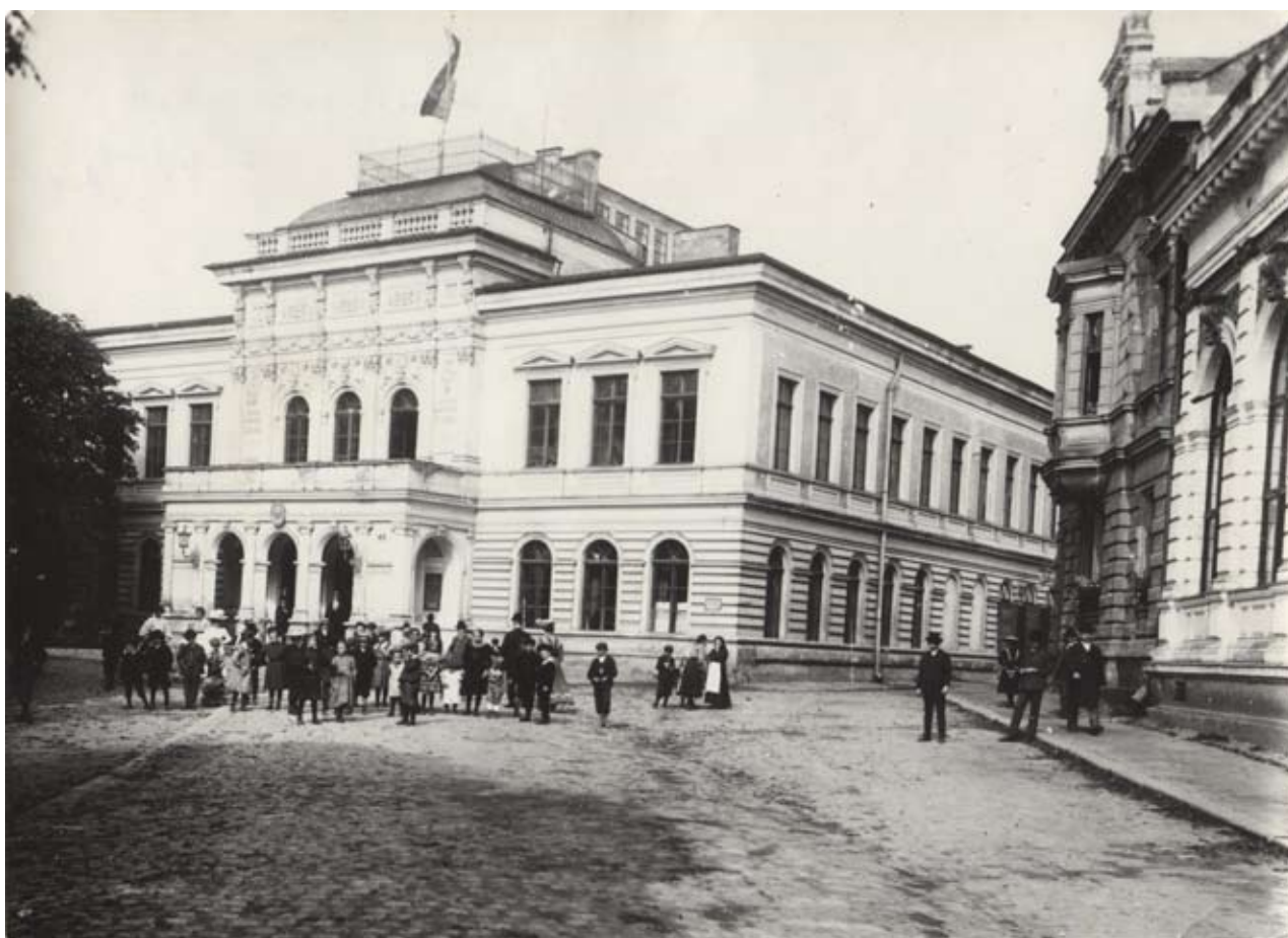
Obr. 78: Obvyklý pohled na Hankův dům, doba Rakousko-Uherska, po roce 1896 (F665/11, Hankův dům, archiv Městského muzea ve DKnL, Městské muzeum DKnL).
