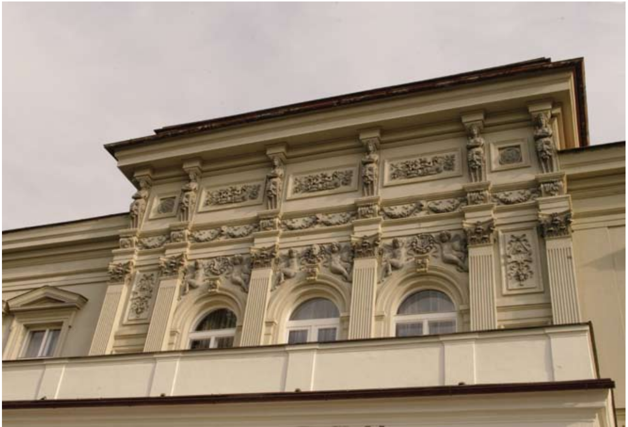
Obr. 147: Dominující střední díl jižního průčelí opatřený bohatou štukovou výzdobou (Kudrnovský, 2015).
