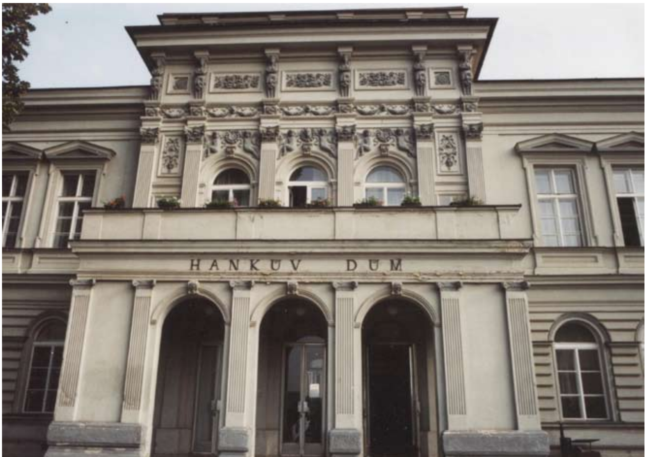
Obr. 132: Pohled na hlavní průčelí Hankova domu, nedatováno (138307, Hankův dům, fotosbírka ÚOP NPÚ v Josefově).
