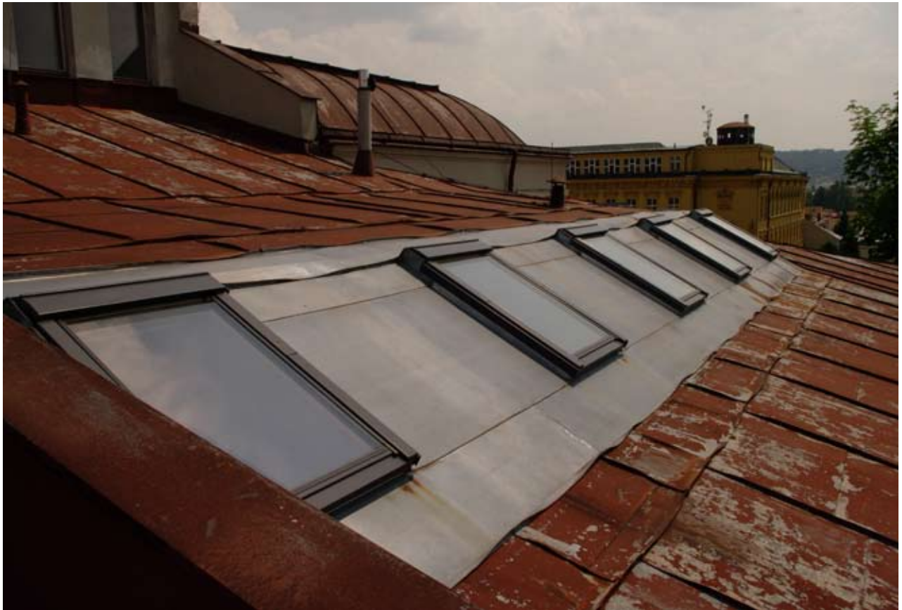
Obr. 174: Pohled na jihozápadní část valbové střechy a báňovou střechu Hankova domu (Kudrnovský, 2015).
