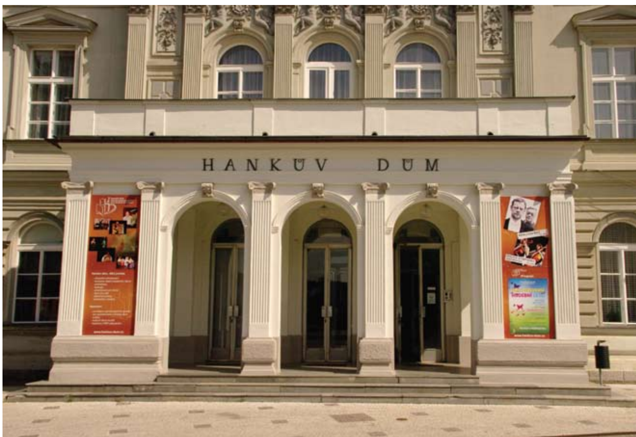
Obr. 139: Pohled na na čelní stranu vstupního portiku (Kudrnovský, 2015).
