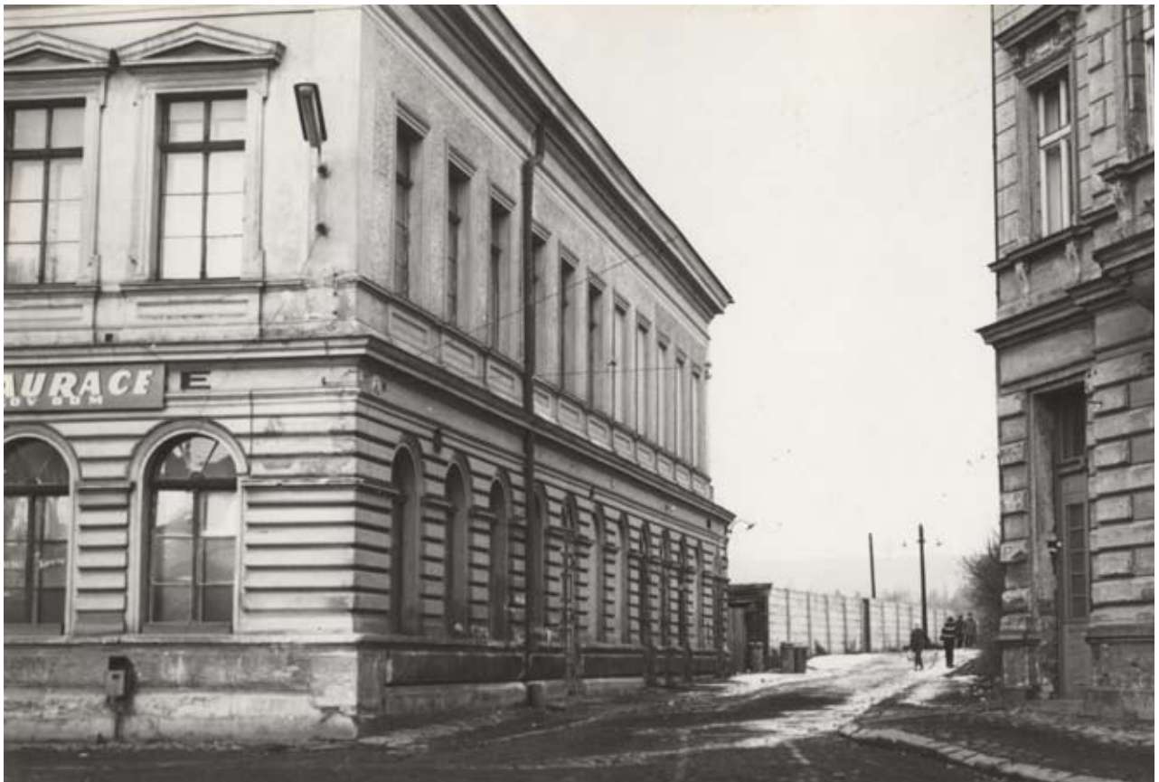
Obr. 97: Pohled na východní průčelí, 1969 (Hankův dům, fotosbírka ÚOP NPÚ v Josefově).
