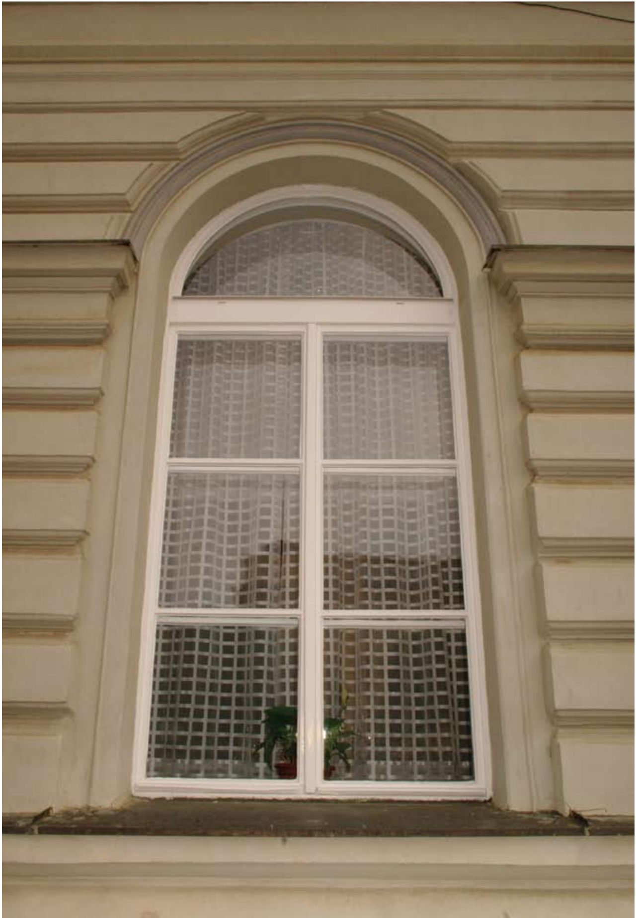
Obr. 166: Pohled na jedno z novodobých špaletových oken s půlkruhovým nadsvětlíkem (Kudrnovský, 2015).
