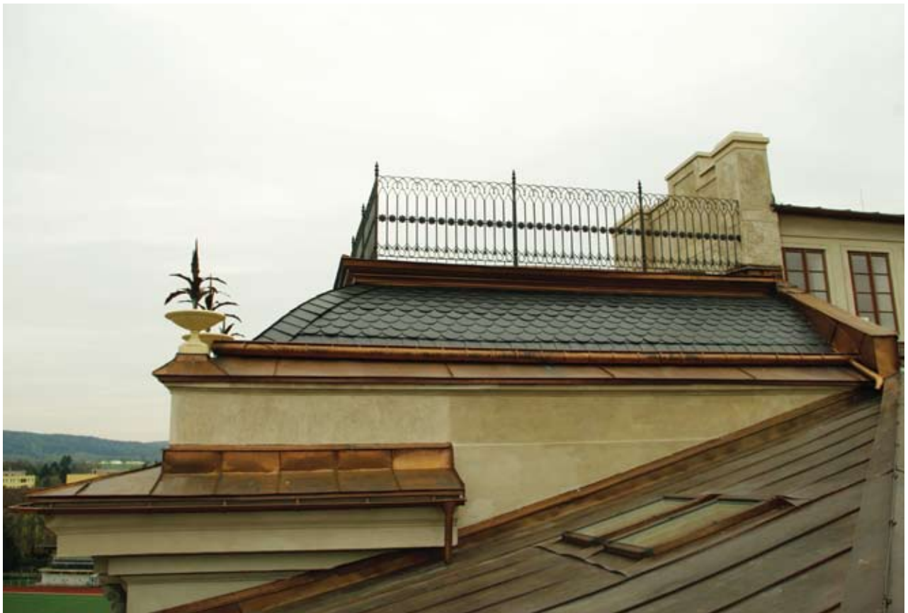
Obr. 181: Pohled na jihovýchodní část střechy Hankova domu, báňovou střechu a část báňové střechy (Kudrnovský, 2017).
