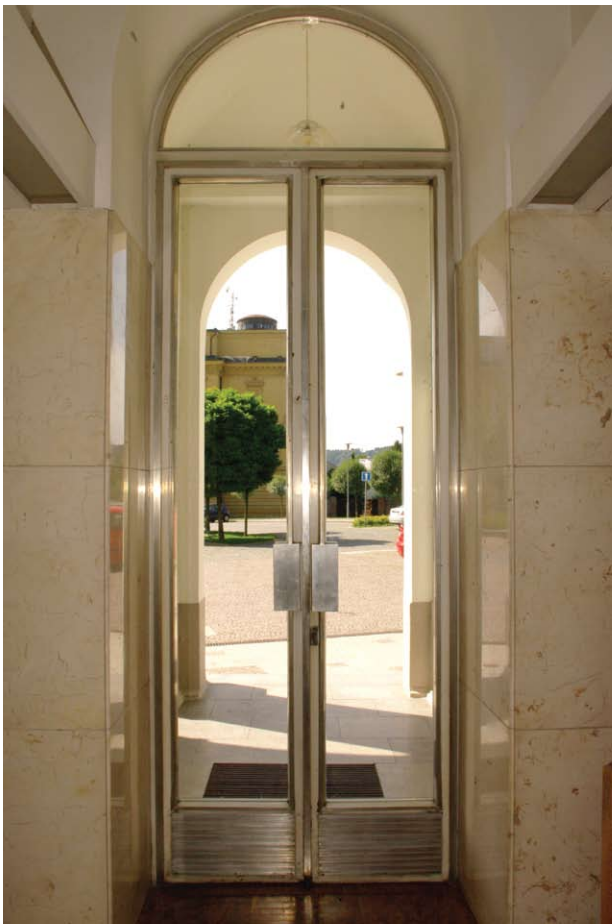
Obr. 164: Pohled na novodobé vstupní dveře z interiéru (Kudrnovský, 2015).
