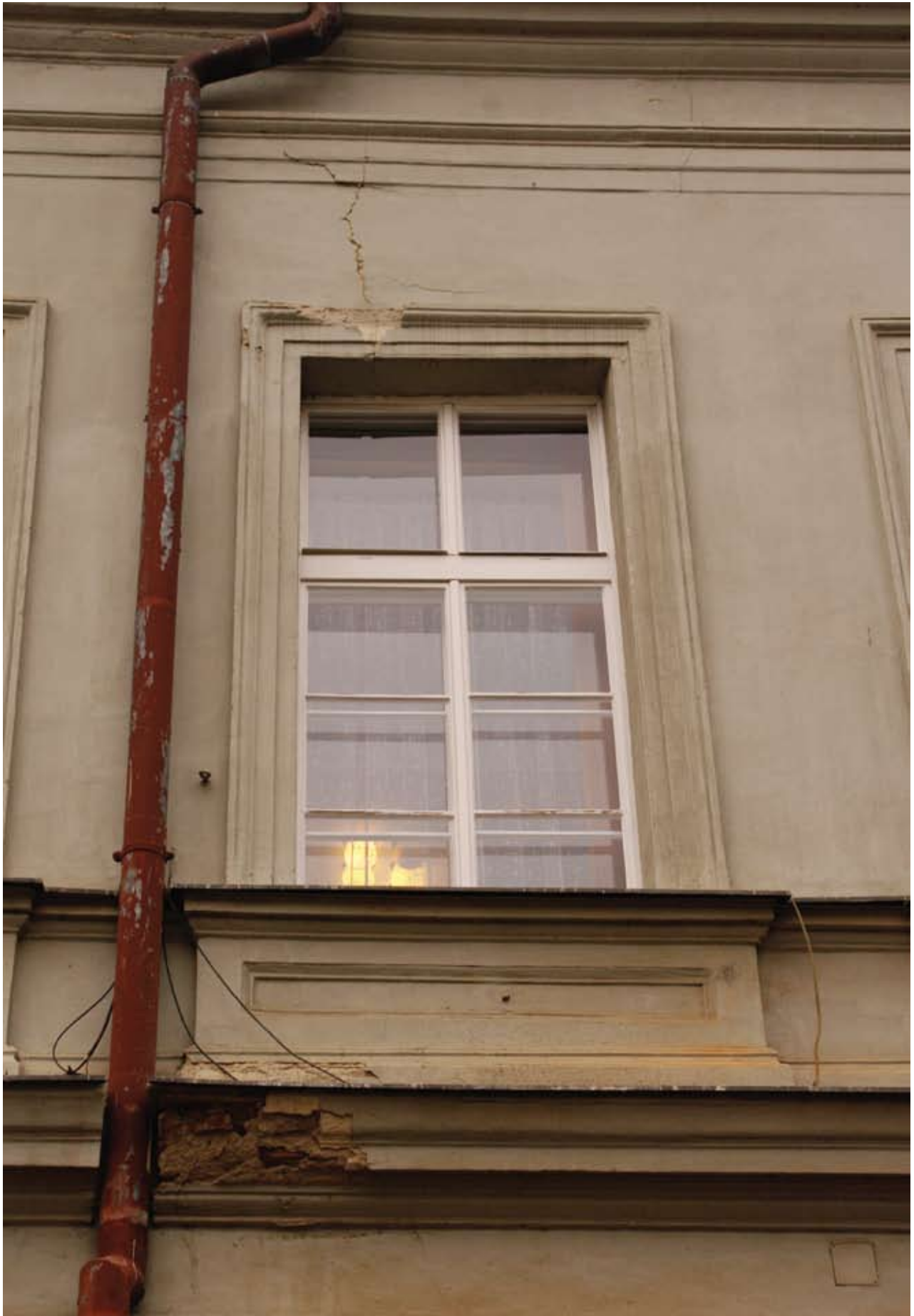
Obr. 168: Pohled na jedno z novodobých špaletových oken s rovným nadpražím (Kudrnovský, 2015).
