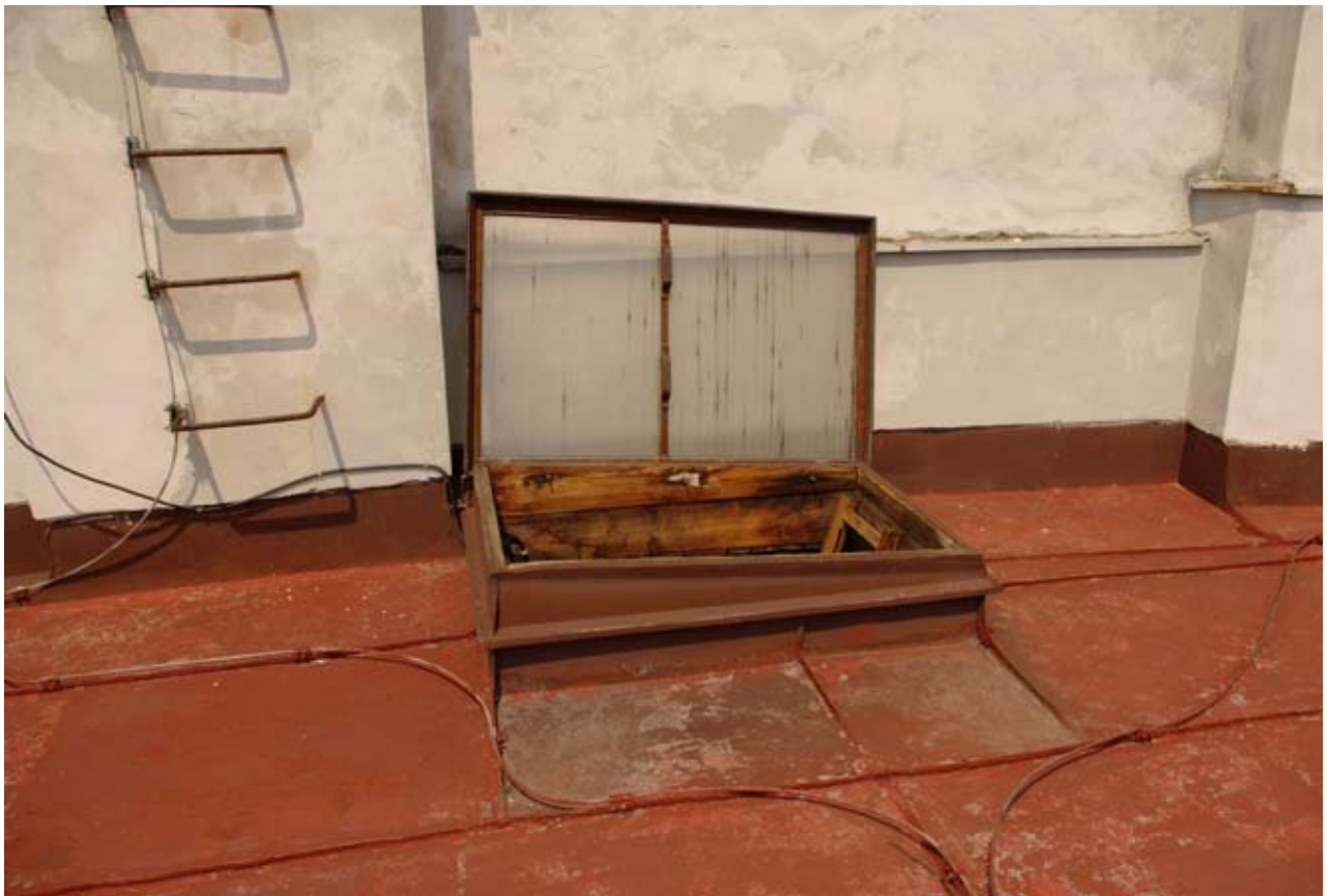
Obr. 183: Střešní výlez situovaný na temeni báňové střechy (Kudrnovský, 2015).
