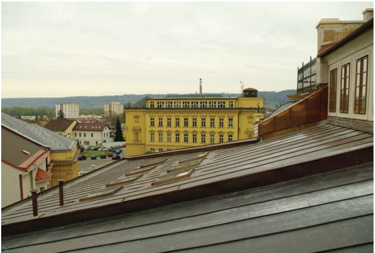
Obr. 179: Pohled na východní část střechy Hankova domu od severu (Kudrnovský, 2017).
