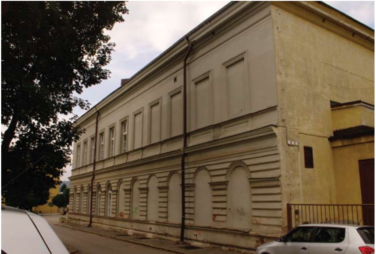
Obr. 155: Pohled na východní průčelí Hankova domu (Kudrnovský 2015).
