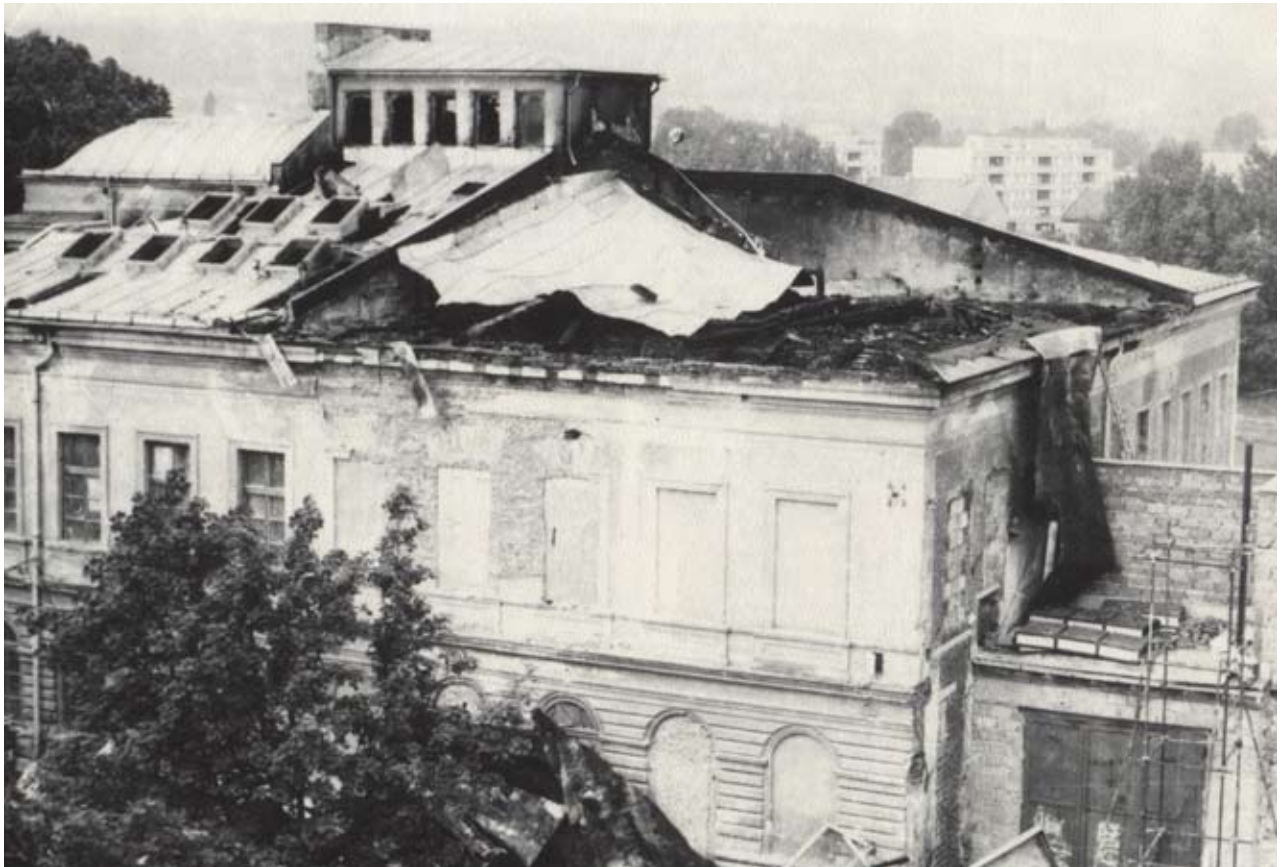
Obr. 122: Požár severovýchodní části střechy vzniklý při svařování nosníků, 1974 (5541/99, Hankův dům, Geislerova sbírka, Městské muzeum DKnL).
