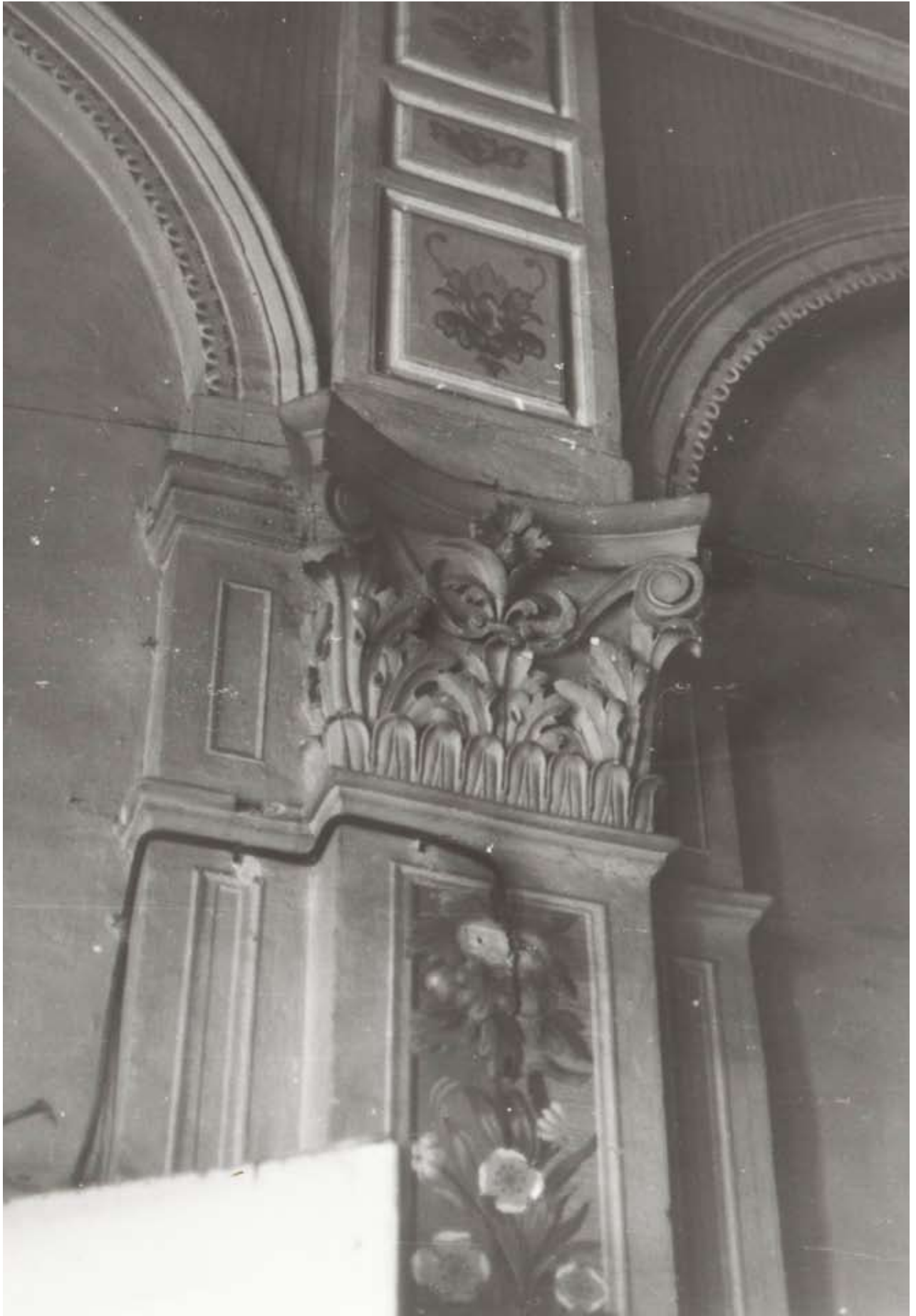
Obr. 110: Interiér Hankova domu před jeho obnovou, 1971 (47823, Hankův dům, fotosbírka ÚOP NPÚ v Josefově).
