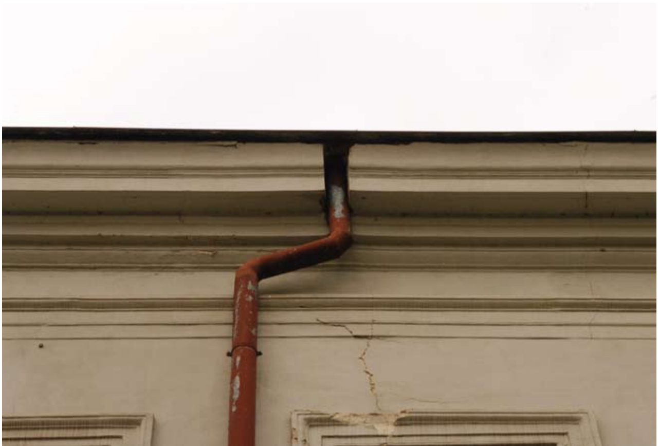
Obr. 161: Pohled na výrazně vyloženou korunní římsu s procházejícím svodem (Kudrnovský, 2015).
