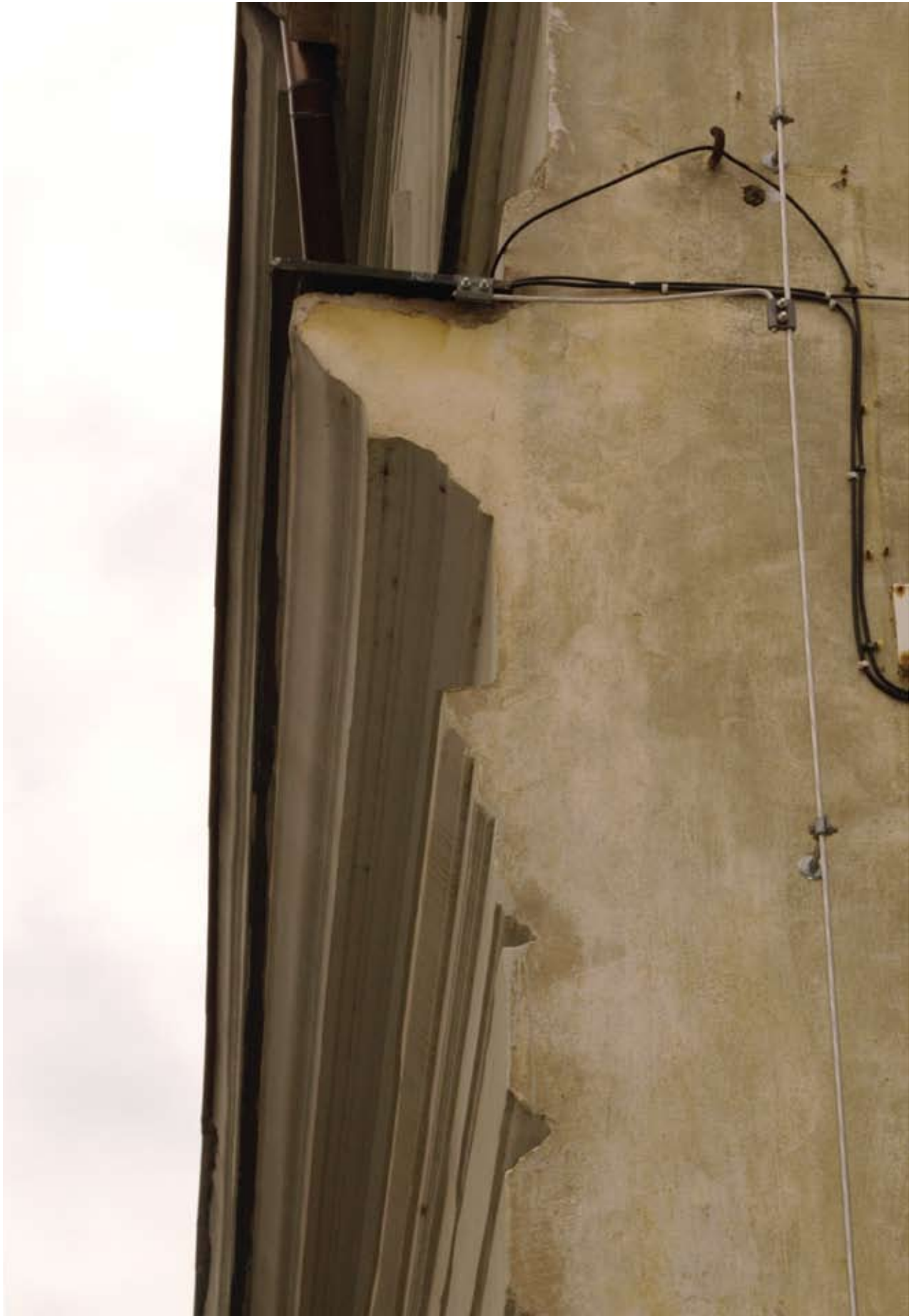
Obr. 162: Detailní pohled na profilaci kordonové římsy (Kudrnovský, 2015).
