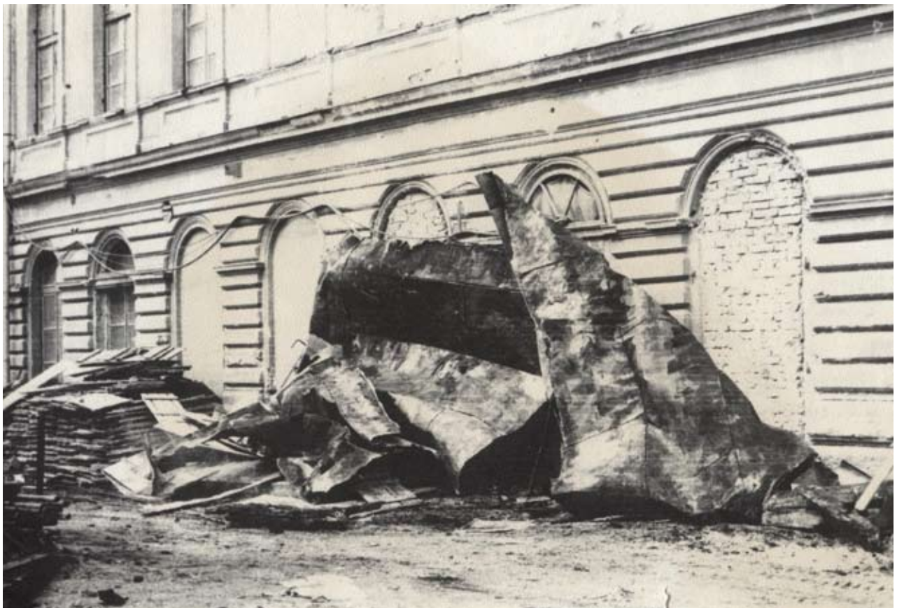
Obr. 123: Plechová krytina po požáru vzniklém při obnově Hankova domu, 1974 (5542/99, Hankův dům, Geislerova sbírka, Městské muzeum DKnL).
