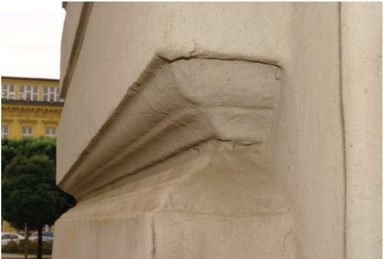
Obr. 159: Detailní pohled na profilaci pásové bosy (Kudrnovský, 2015).
