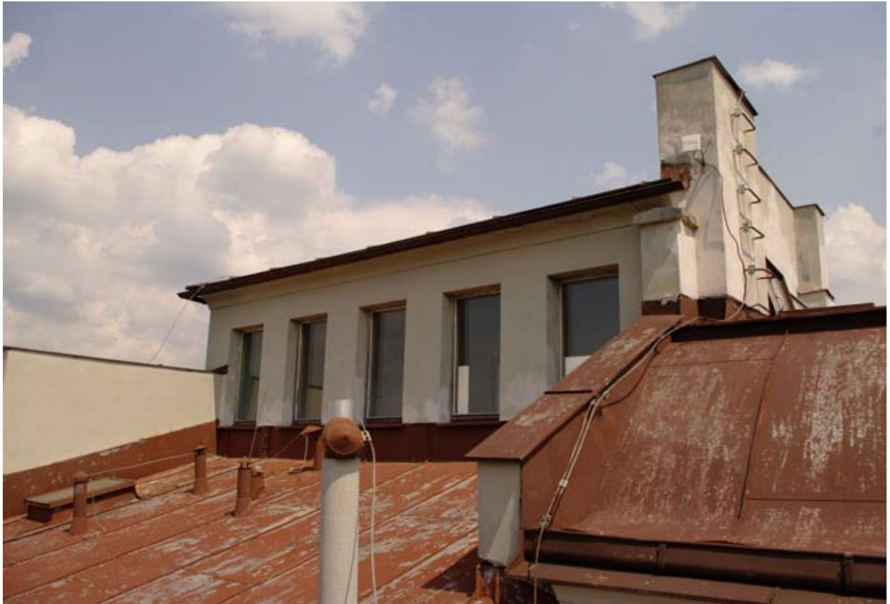
Obr. 172: Pohled na střešní pavilon od jihozápadu (Kudrnovský, 2015).
