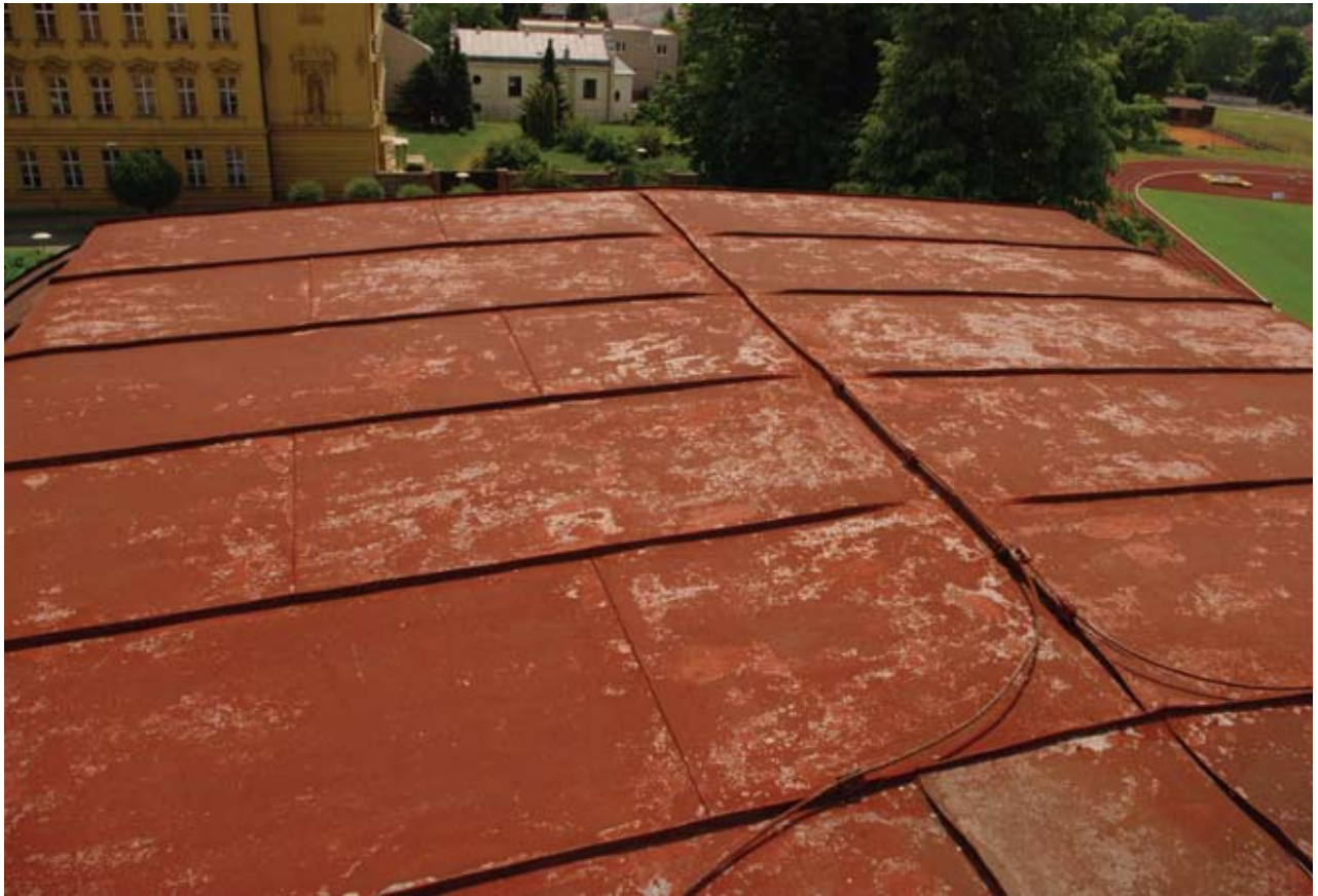
Obr. 182: Pohled na temeno báňové střechy Hankova domu (Kudrnovský, 2015).
