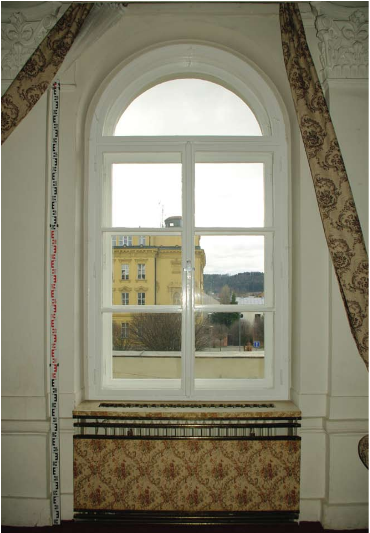
Obr. 167: Pohled na jedno z novodobých špaletových oken s půlkruhovým nadsvětlíkem (Kudrnovský, 2015).
