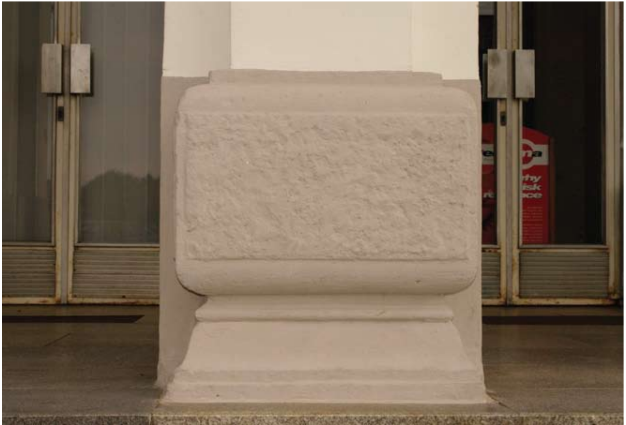
Obr. 143: Pohled na střední patku pilíře vstupního portiku (Kudrnovský, 2015).
