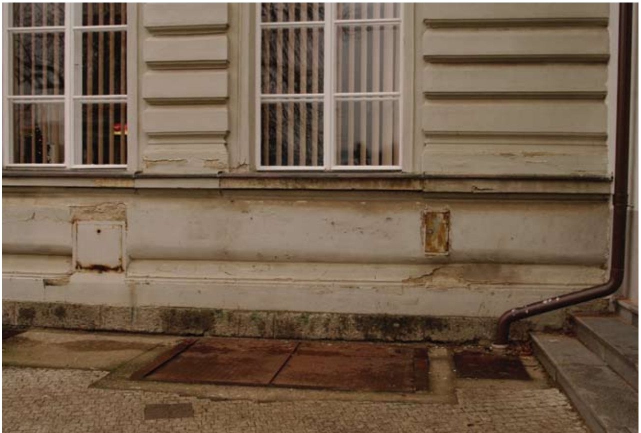
Obr. 144: Detailní pohled na trnož západního dílu jižního průčelí (Kudrnovský, 2015).
