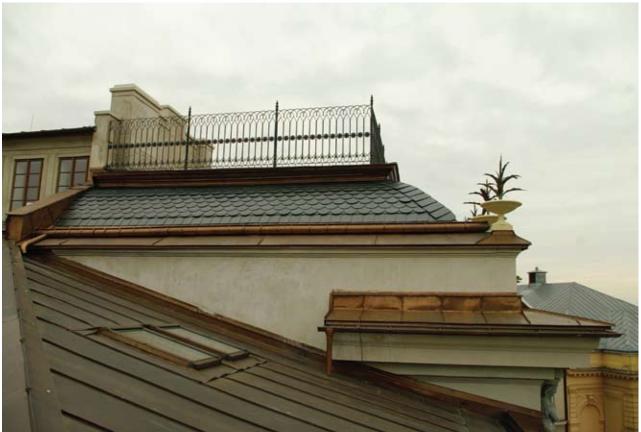
Obr. 171: Pohled na jihozápadní část valbové střechy a báňovou střechu Hankova domu (Kudrnovský, 2017).
