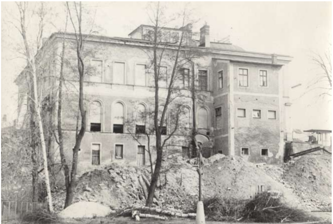
Obr. 101: Pohled na západní průčelí Hankova domu, nedatováno (5517/99, Hankův dům, Geislerova sbírka, Městské muzeum DKnL).
