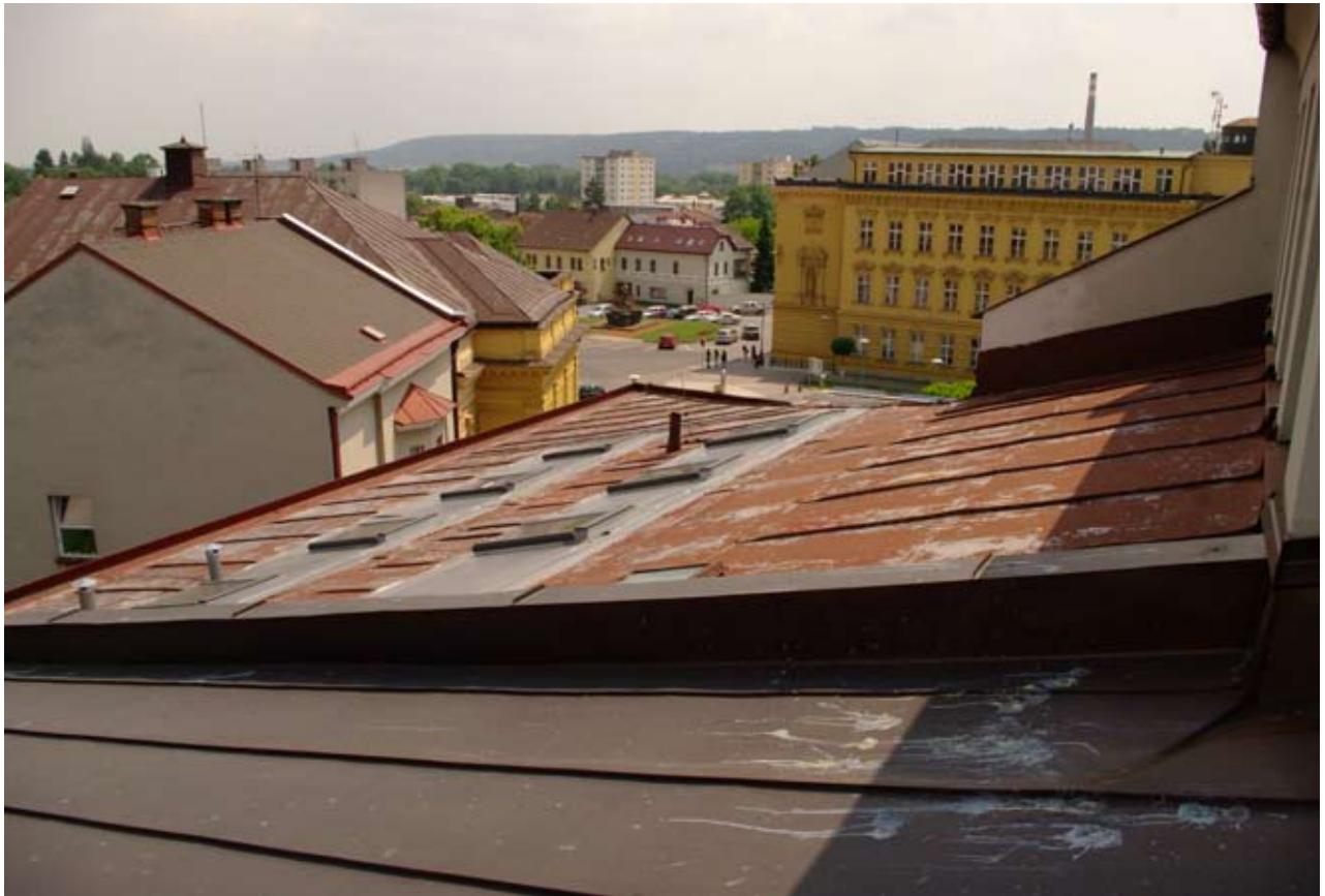
Obr. 178: Pohled na východní část střechy Hankova domu od severu (Kudrnovský, 2015).
