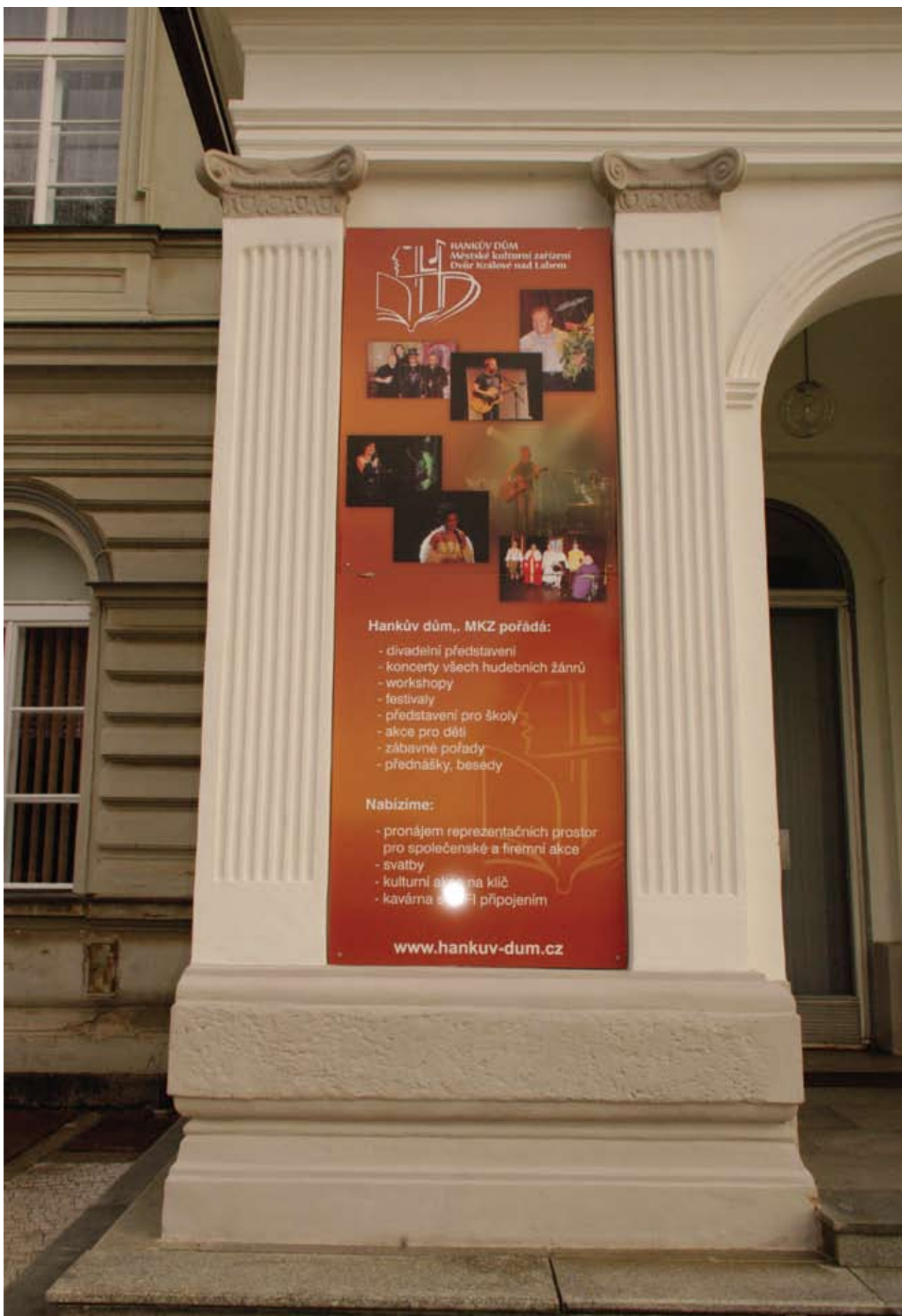
Obr. 141: Pohled na krajní patku pilíře vstupního portiku (Kudrnovský, 2015).
