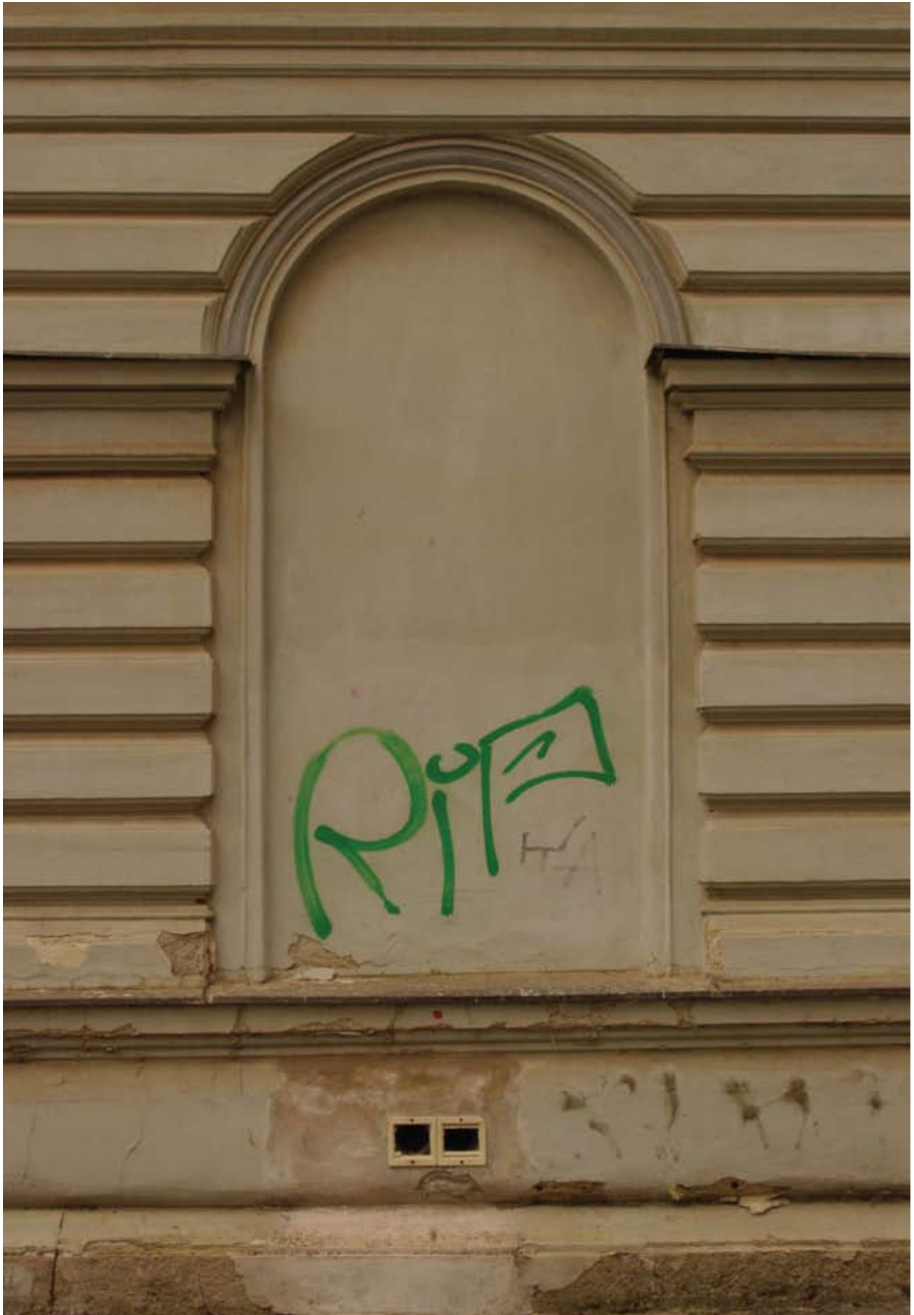
Obr. 157: Pohled na zadržku okna ve východním průčelí (Kudrnovský, 2015).
