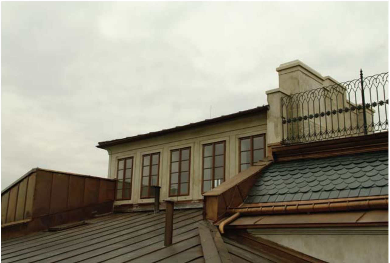
Obr. 173: Pohled na střešní pavilon od jihozápadu (Kudrnovský, 2017).
