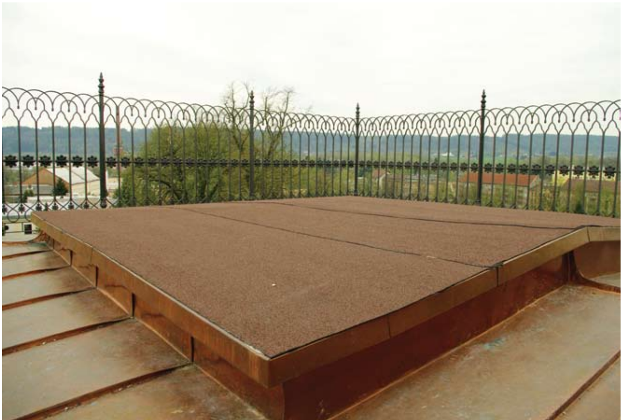
Obr. 185: Pohled na temeno báňové střechy s replikou původního zábradlí (Kudrnovský, 2017).
