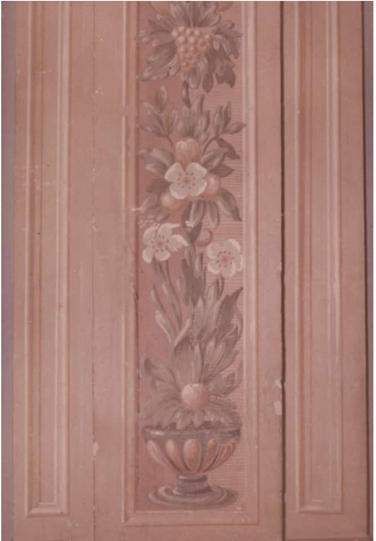
Obr. 111: Interiér Hankova domu před jeho obnovou, 1971 (Hankův dům, fotosbírka ÚOP NPÚ v Josefově).
