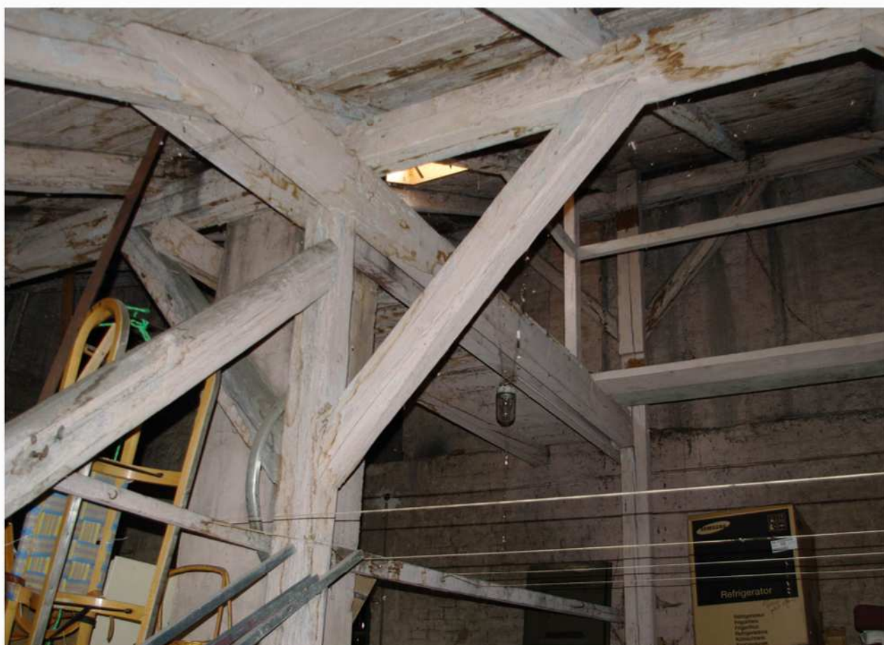
Obr. 8: Pohled na část plné vazby krovu s lávkami zpřístupňujícími střešní otvor (foto: M. Kudrnovský).
