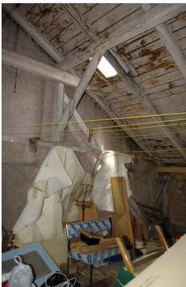
Obr. 2: Plná vazba krovu přisedající k západní štítové zdi (foto: M. Kudrnovský).
