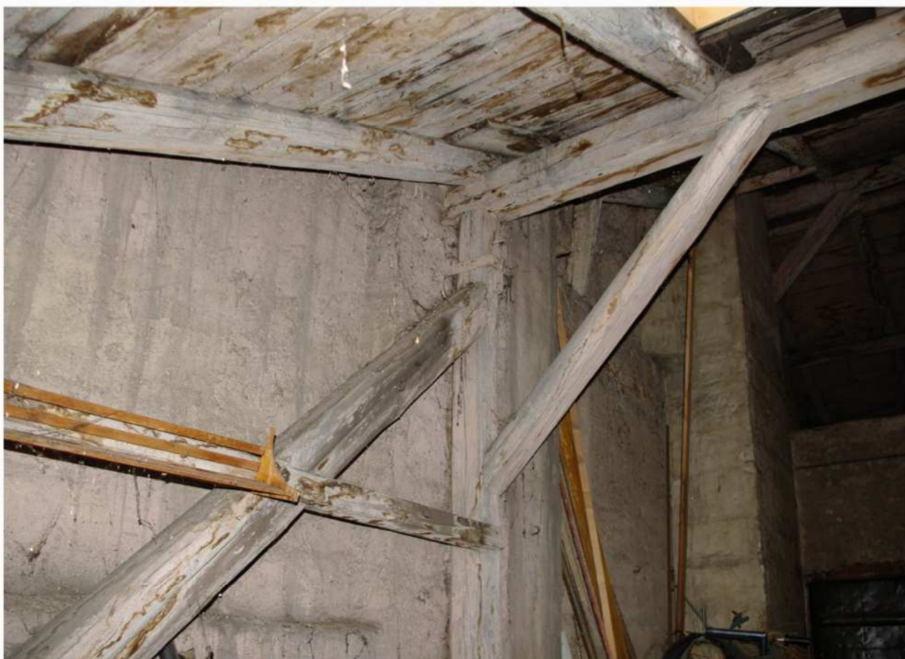
Obr. 10: Pohled na část plné vazby přisedající k východní štítové zdi, 2012 (foto: M. Kudrnovský).
