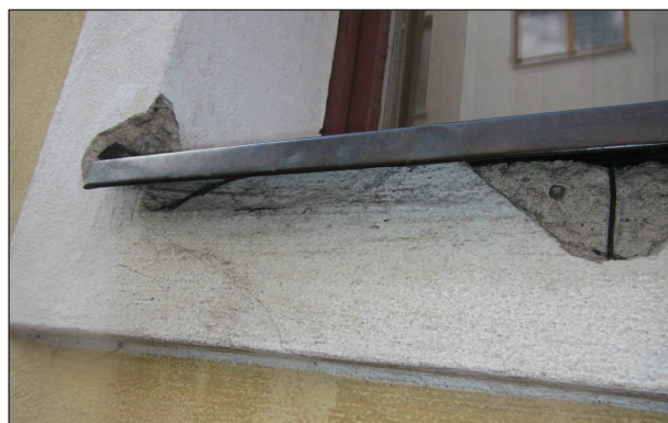
Nutná oprava přichycení stávajícího parapetu
