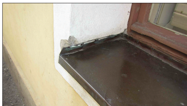
Nutná oprava omítky okolo stávajícího parapetu
