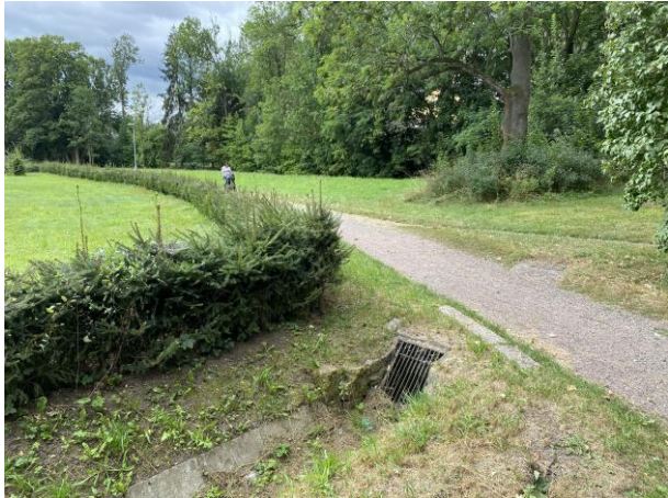
Pohled na mříž na odtoku drenážní rýhy do Hartského potoka pro případný převod přetoku z vrtu DKR-3.
