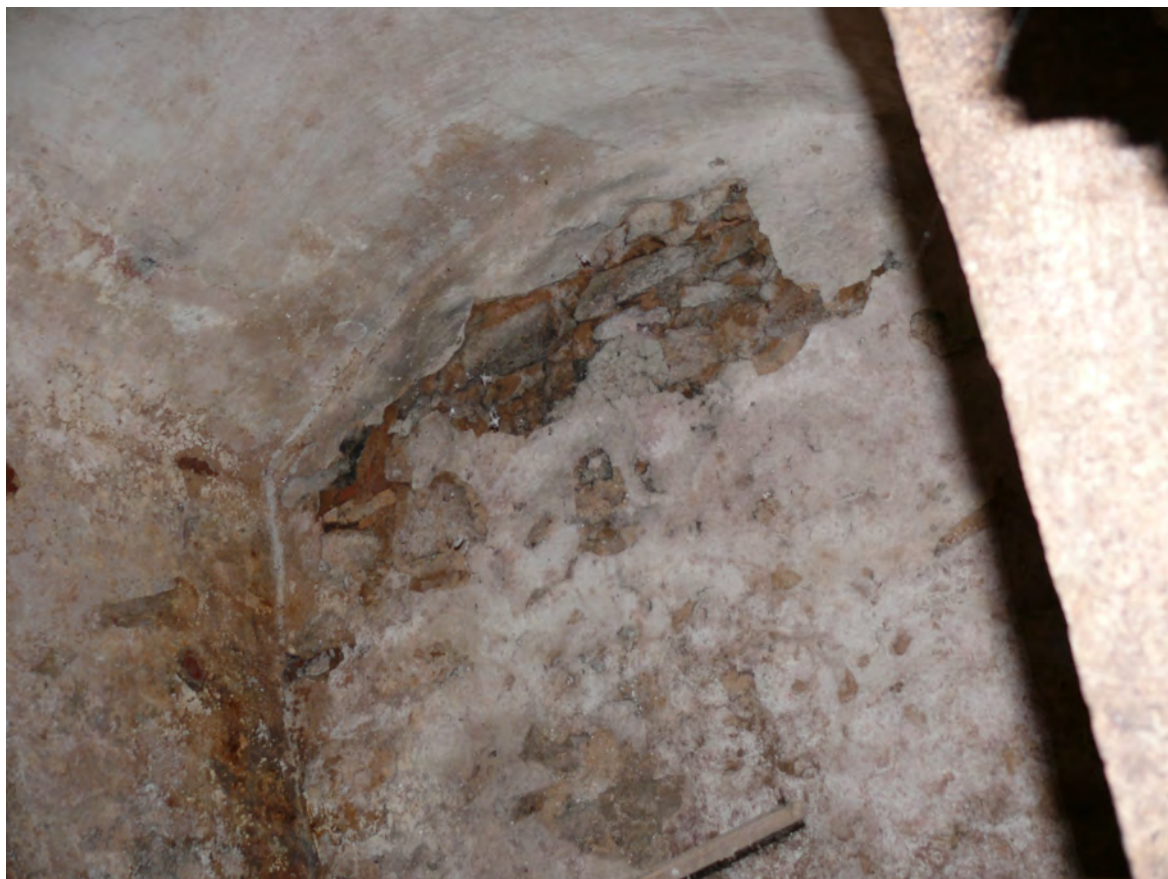
066 Severní čelo západního sklípku
