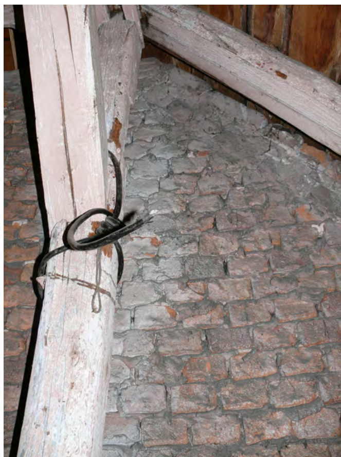
110 Vazba cihel v západní části štítu
