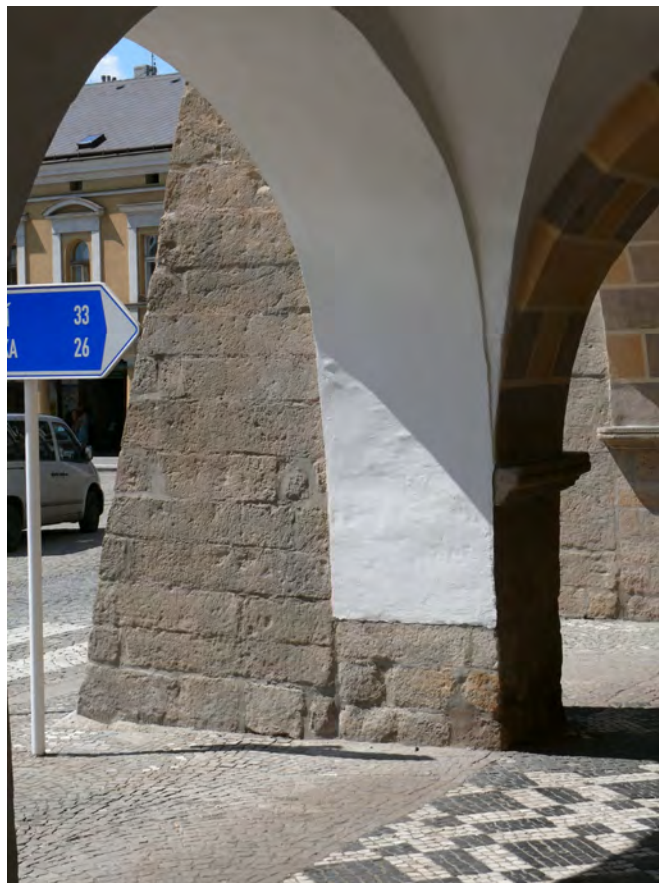
011 Západní pilíř podloubí s opěrákem
