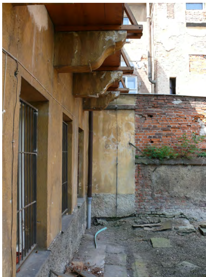
018 Průhled pod pavlačí k západu
