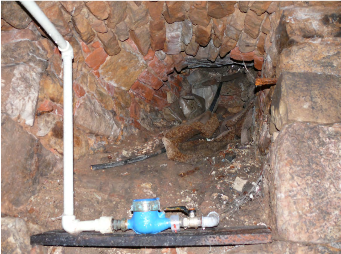
055 Pohled do větráku předního sklepa
