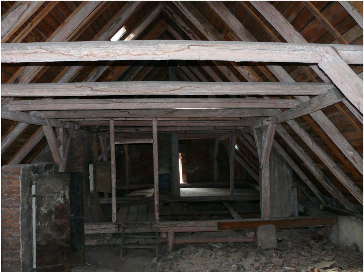
099 Průhled krovem k jihu s torzem příčky
