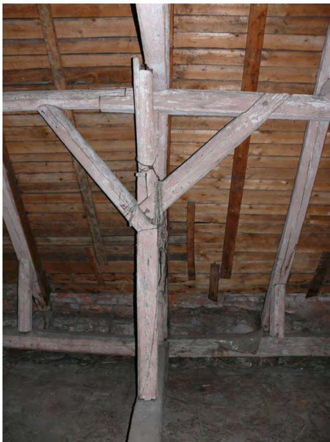
104 Sloupek plné vazby, napojení vaznic
