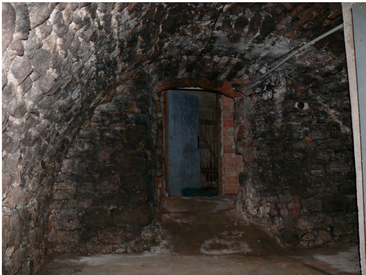
051 Suterén - přední sklep, severní stěna
