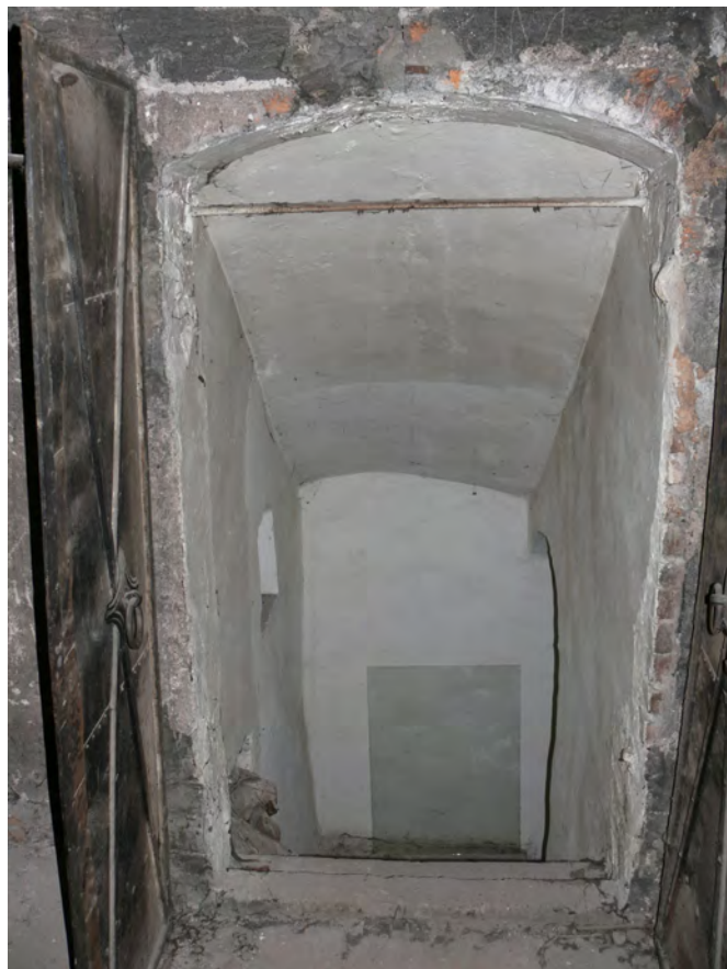
093 Pohled shora do schodiště do krovu
