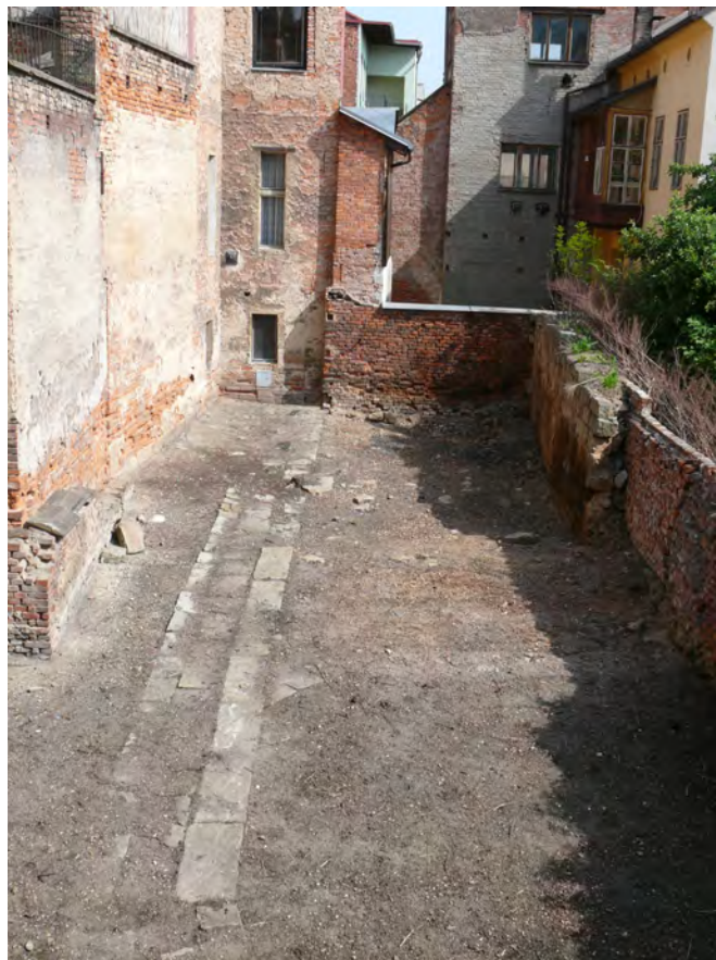
023 Severní část dvorku zpavlače
