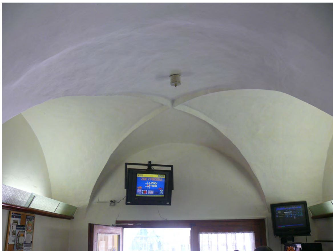
042 Jižní část kleneb v průhledu k jihu
