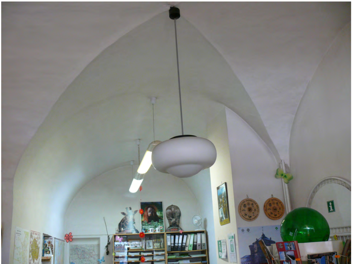
036 Východní krámk - severní část kleneb
