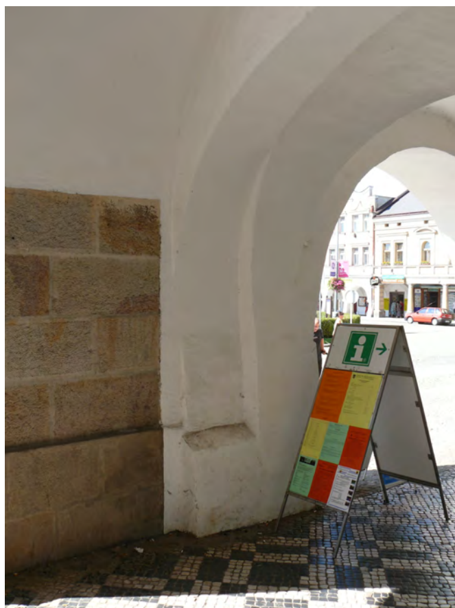
010 Východní pilíř podloubí
