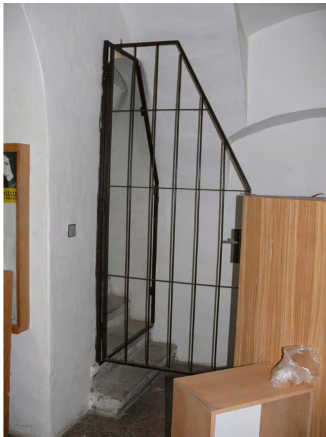
075 Nástup na schodiště do krovu
