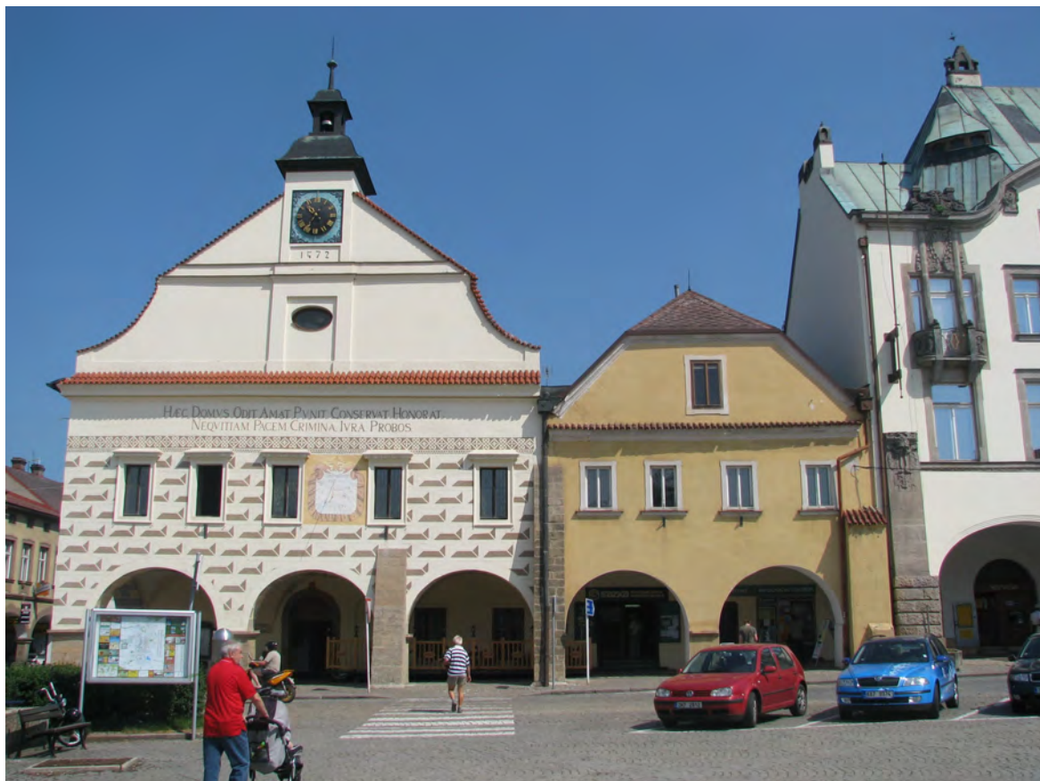
001 Celkový pohled s navazující zástavbou
