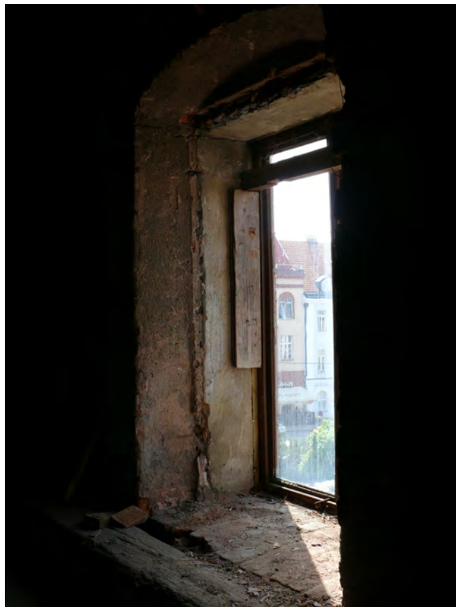
109 Pohled do špalety okna do náměstí
