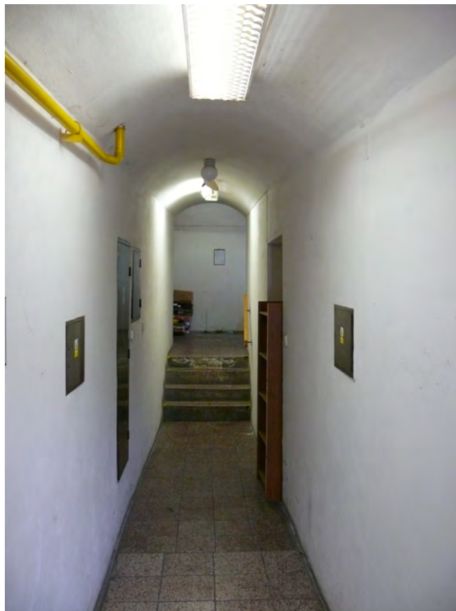
029 Přízemí - průhled vstupní chodbou k severu
