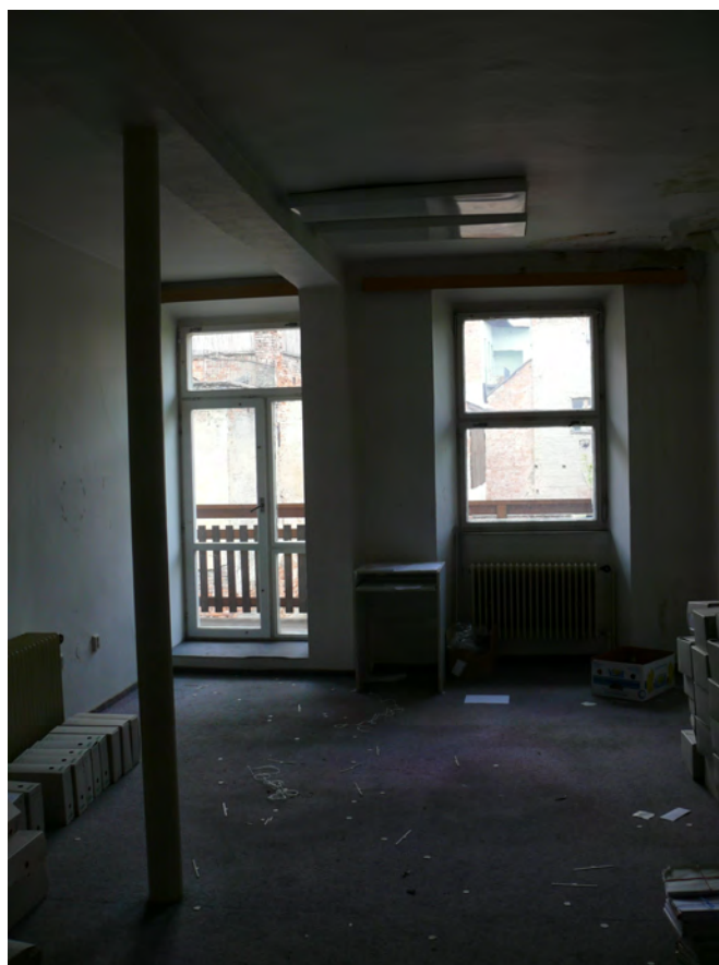
090 Severní stěna severovýchodní místnosti
