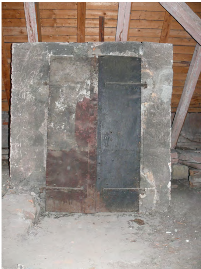
095 Výstup schodiště na půdu (rub dveří)
