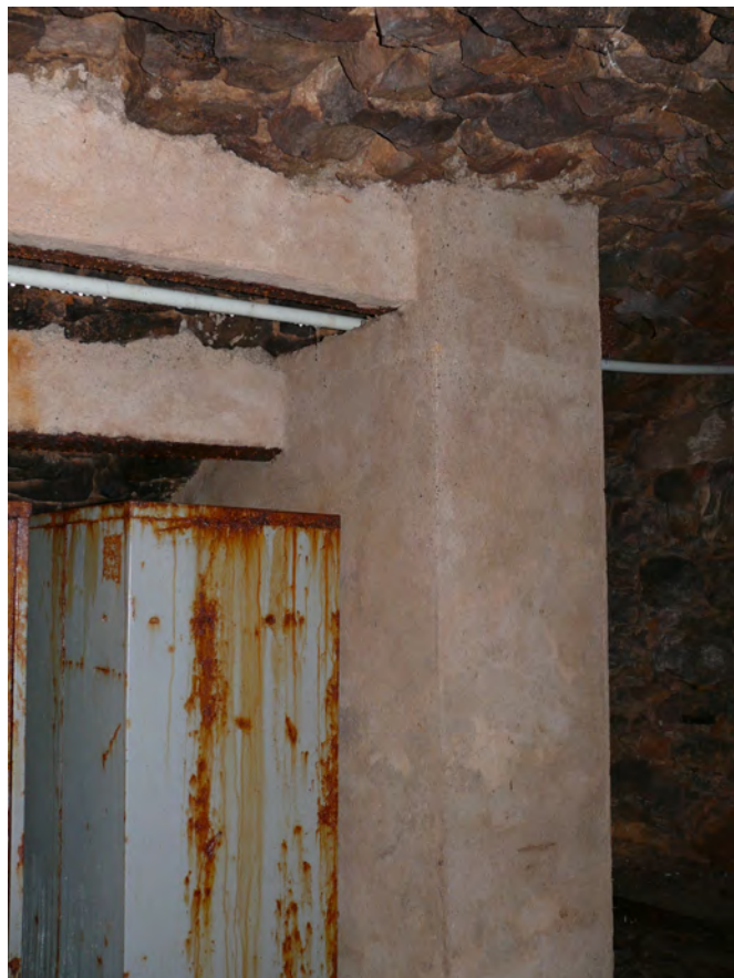
053 Detail opěrného pilíře předního sklepa
