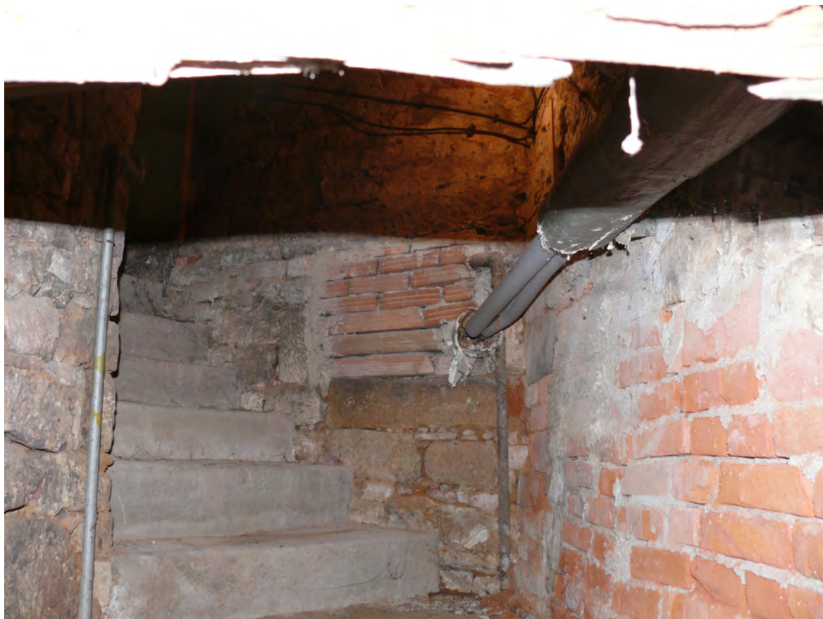
067 Průhled do schodiště se zazděným výklenkem
