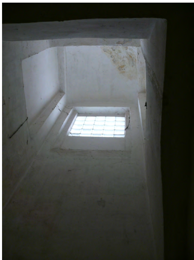
078 Severní stěna světlíku
