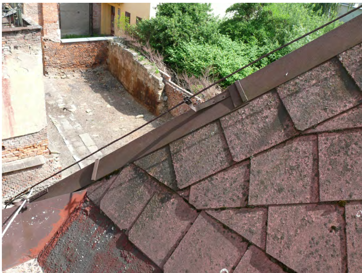
026 Detail nároží střechy
