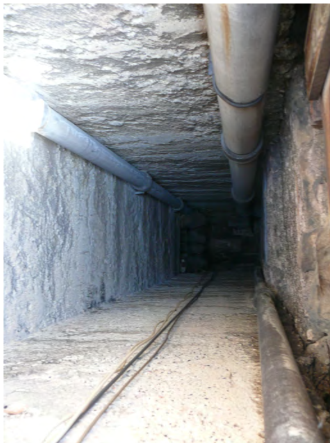
028 Pohled do šachty čp. 1 s omítanou plochou
