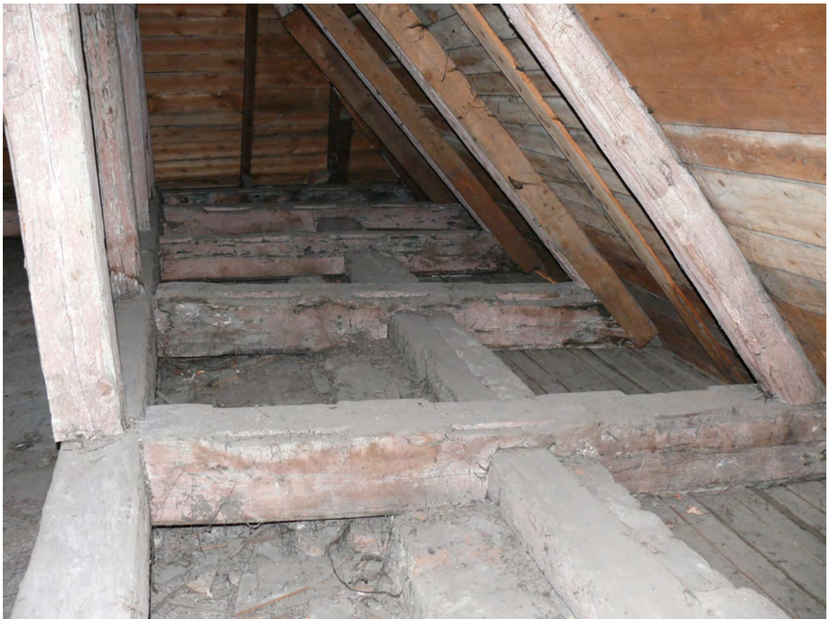
106 Druhotně použité stropní trámy v severozápadní části krovu
