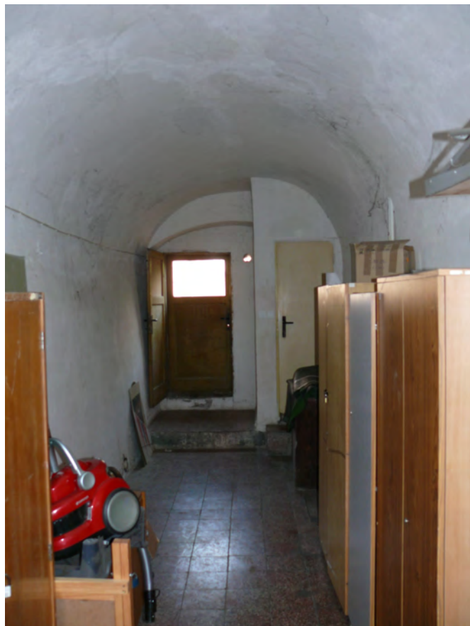
033 Severní průhled chodbou na dvůr
