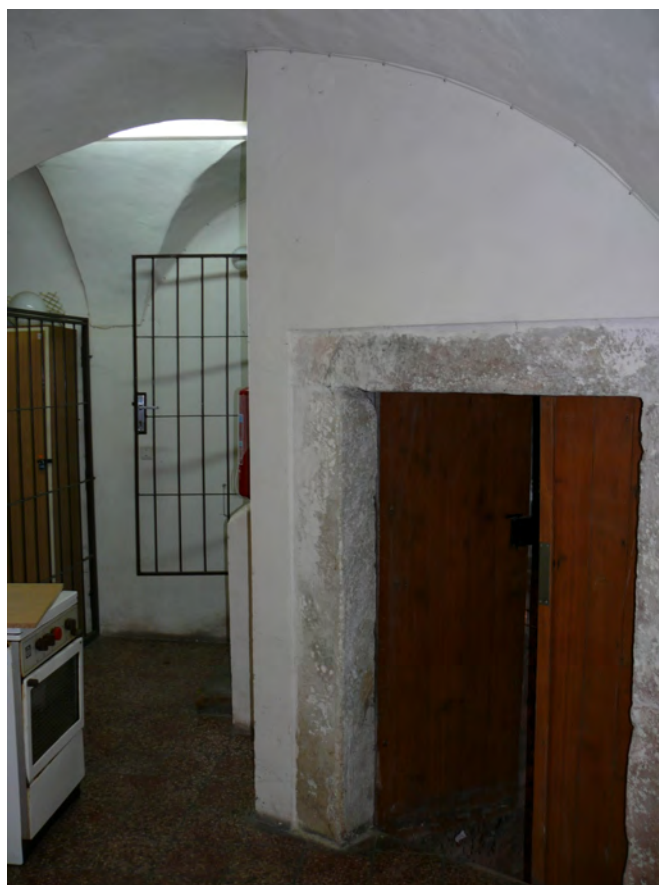
032 Východní část síně se vstupem do sklepa
