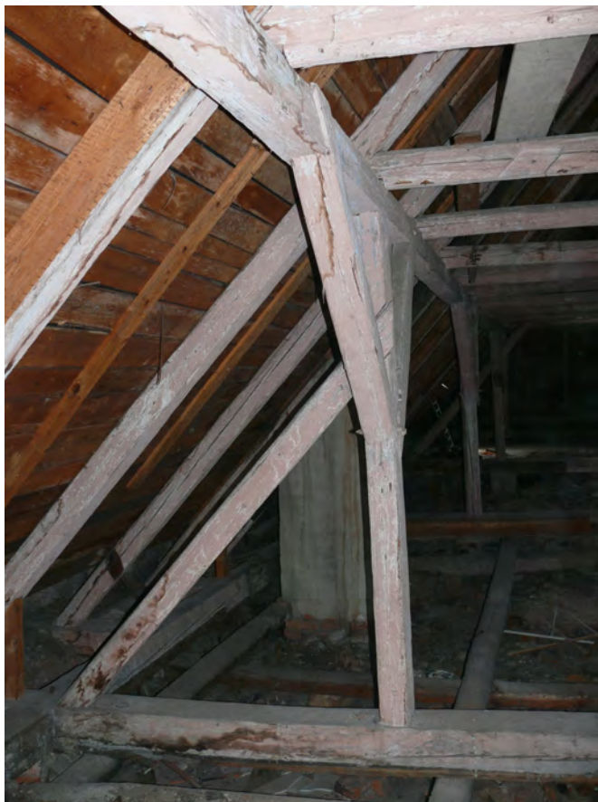
103 Západní část krovu s částí plné vazby
