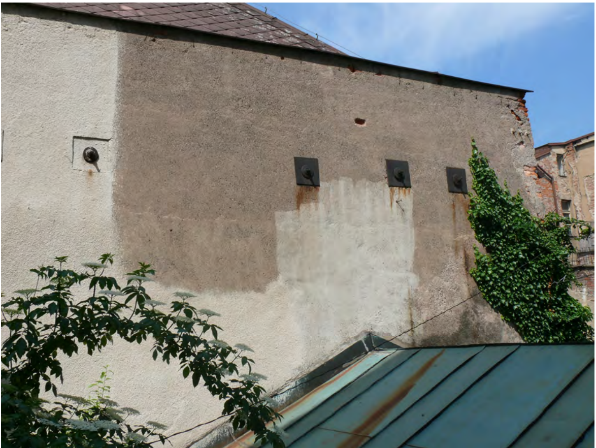
022 Severní část východní stěny
