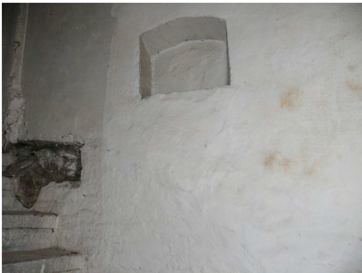
092 Severní stěna schodiště do krovu s výklenkem a zadržkou pod klenbou (dole)
