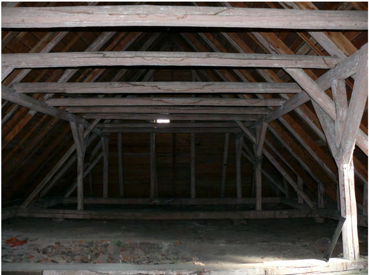
100 Průhled krovem k severu
