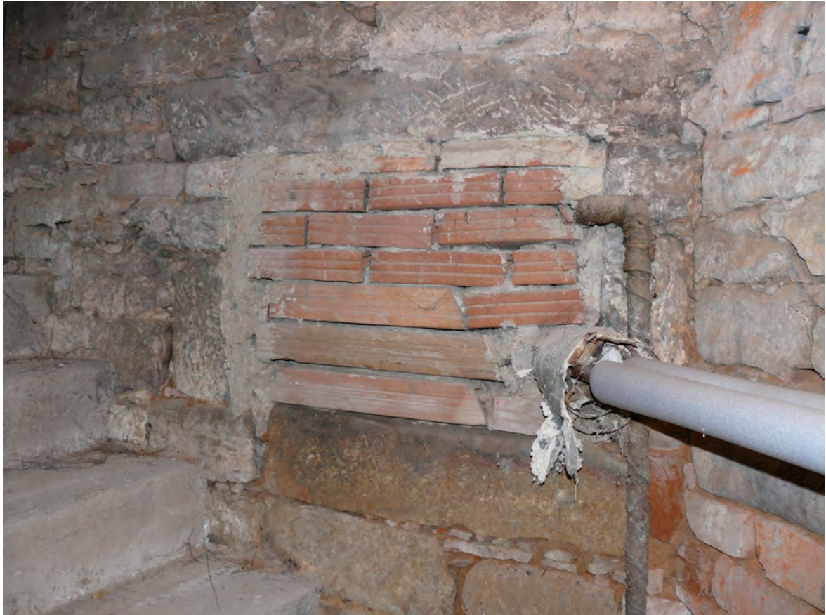
069 Zazděný výklenek na schodišti
