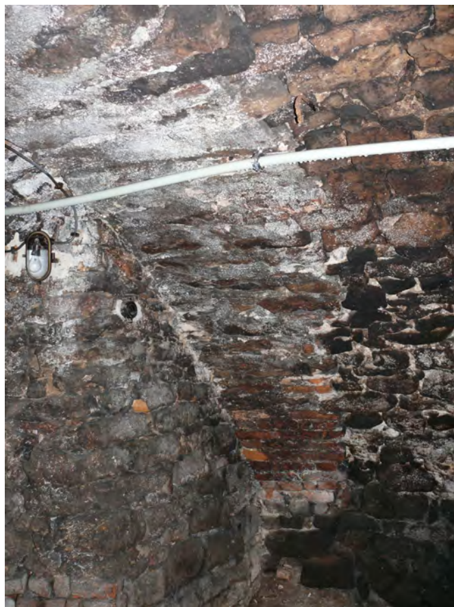
054 Pás vysrávky při severním čele předního sklepa
