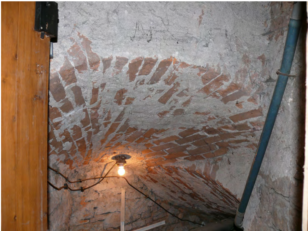
070 Klenba horní části schodiště
