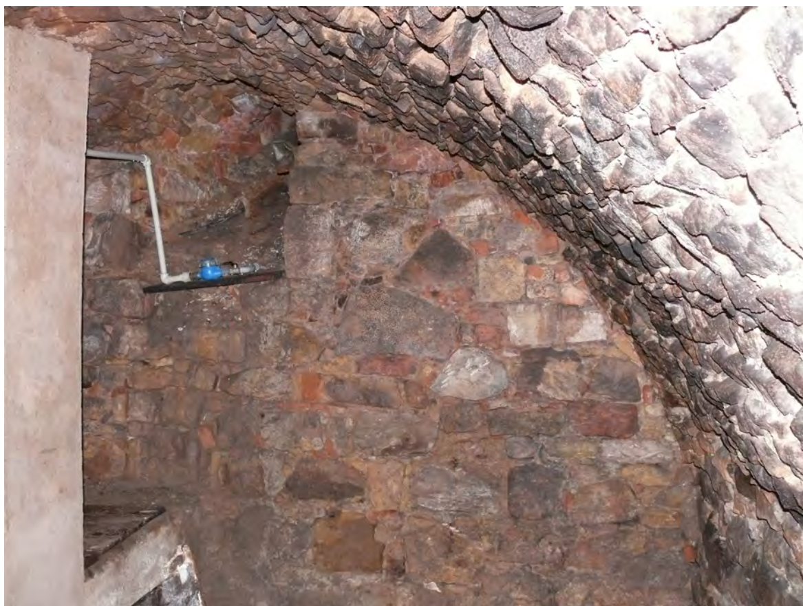
052 Přední sklep, jižní stěna
